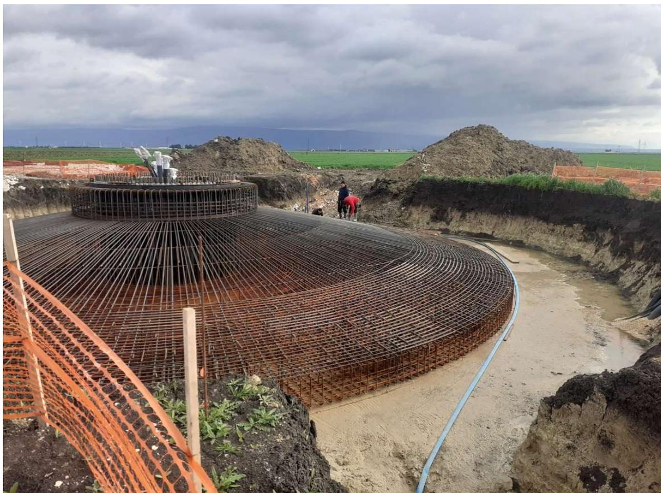
**Fig. 23 Armatura di acciaio del plinto di fondazione.**
