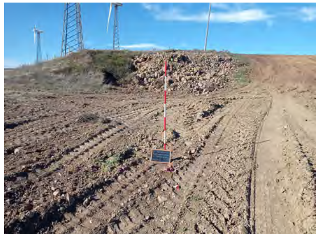
Foto 4: l'area sul cvd MTZ4-MTZ5 oggetto di lavori da recenti.
