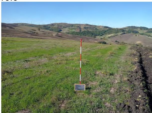
Foto 1: cavidotto MTZ11-MTZ13, vista da E.
