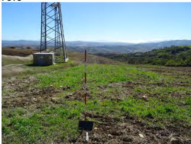
Foto 1: cvd tra MTZ5 e MTZ8, vista da N.
