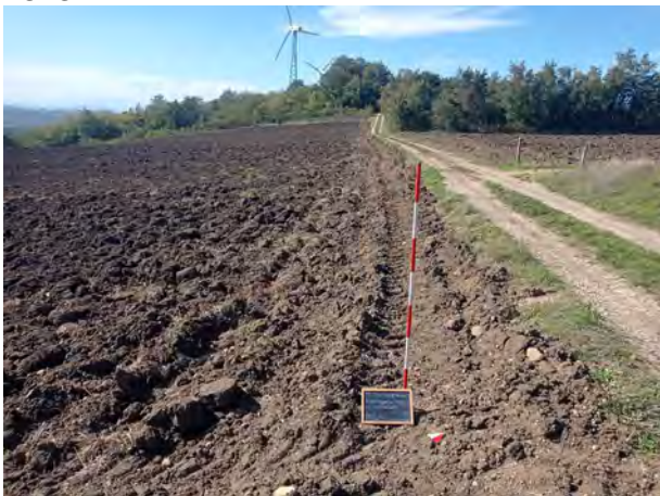
Foto 1: cavidotto MTZ 2 – MTZ2, vista da SE.
