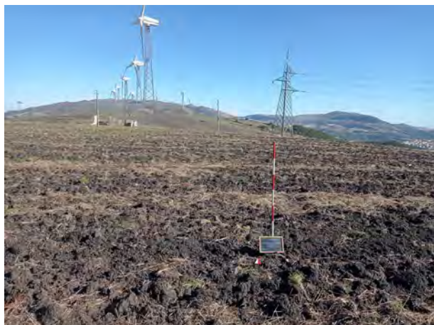
Foto 2: l'area della pala MTZ13, vista da S.
