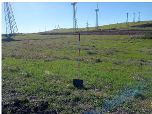
Foto 2: cavidotto MTZ11-MTZ13, vista da S.
