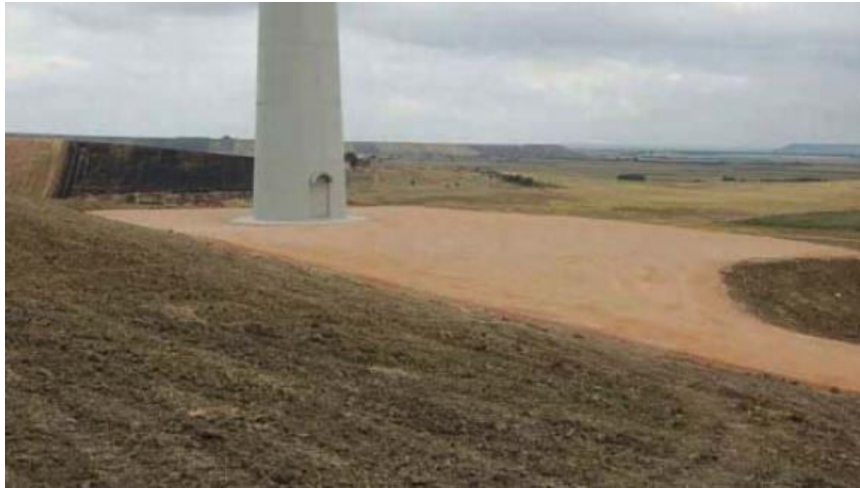
Figura 6.13. – Sistemazione finale di una piazzola-tipo di un aerogeneratore.
