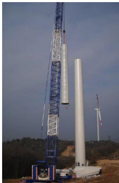
Figura 7. Operazione di montaggio di una torre eolica.
