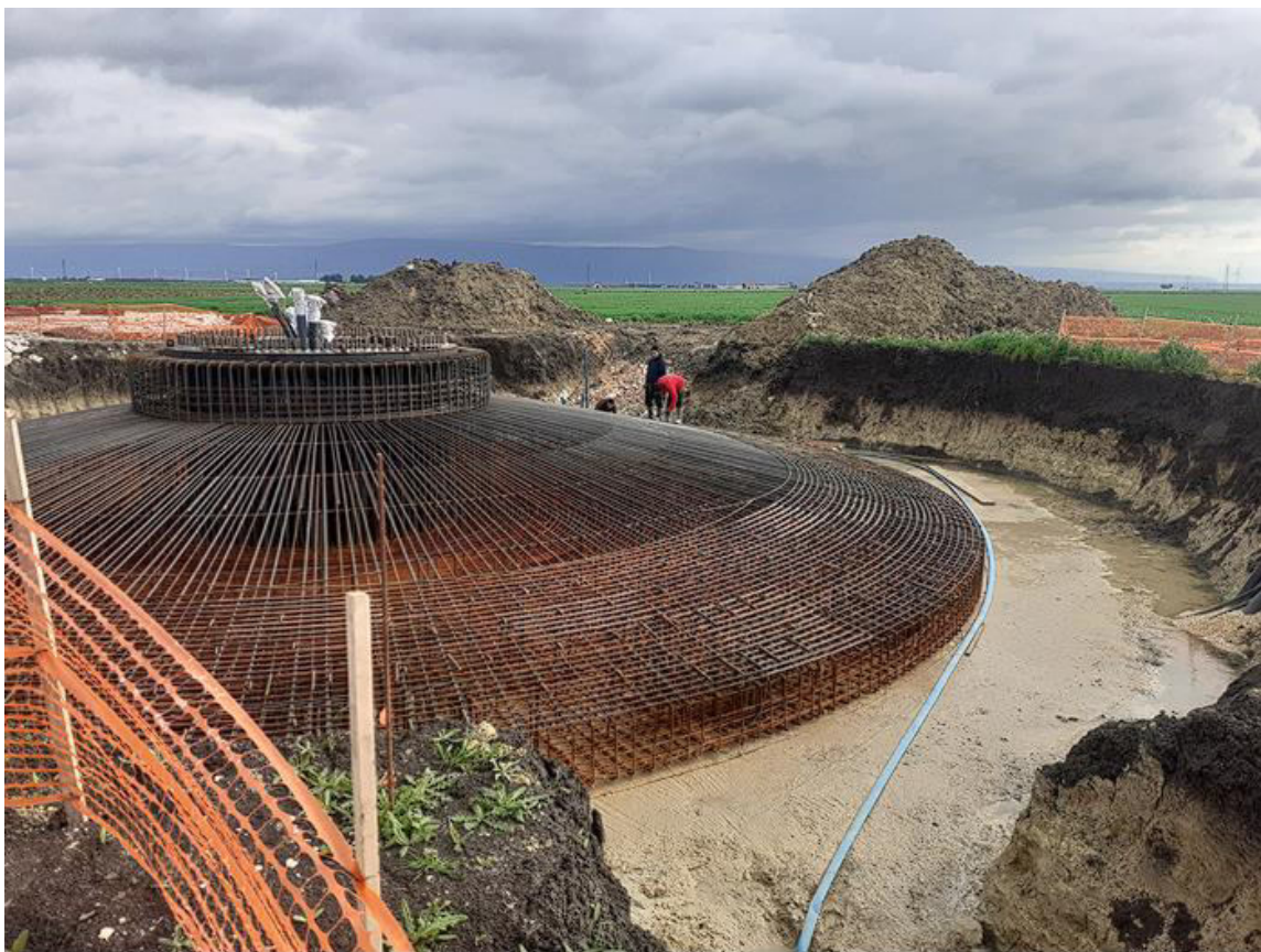
Figura 6.11. – Armatura in acciaio del plinto di fondazione.
