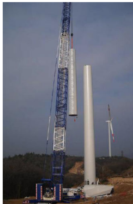
Figura 6.14. – Operazione di montaggio di una torre eolica.
