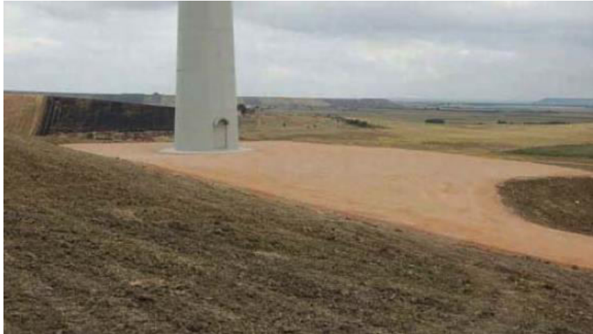
Figura 6. Sistemazione finale di una piazzola-tipo di un aerogeneratore.
