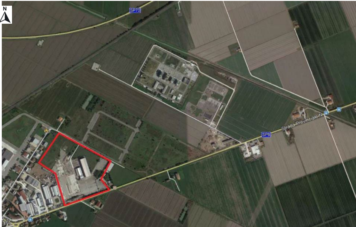
Figura 2-5: Area di cantiere temporanea esterna al sito SNAM
