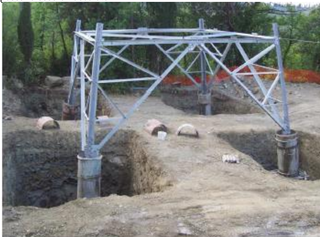
Figura 8-2 - Esempio di scavo per la realizzazione di fondazioni superficiali per un sostegno a traliccio. Si evidenziano le quattro buche, la base del sostegno collegata alla fondazione tramite i "monconi" ed i casseri utilizzati per quattro "colonnini"
