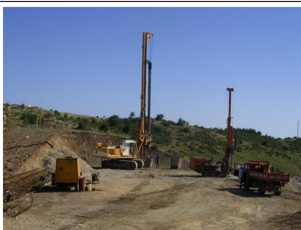
Realizzazione pali trivellati
