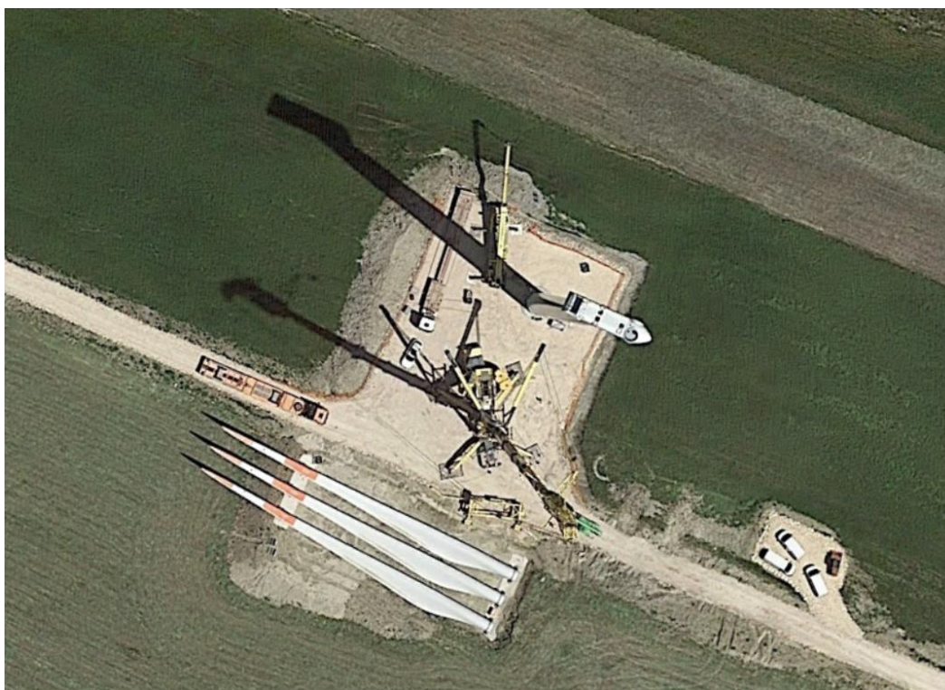
Figura 2.7 – esempio di piazzola in fase di costruzione
