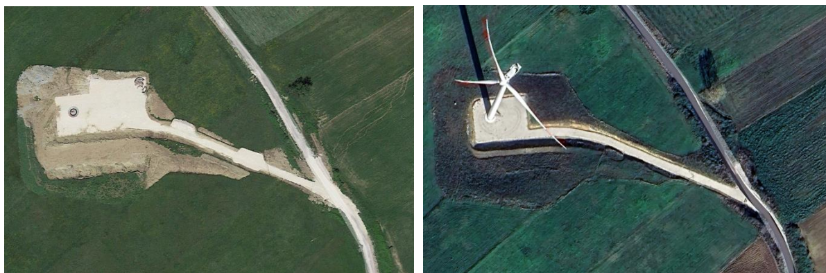
Piazzola in fase di cantiere
