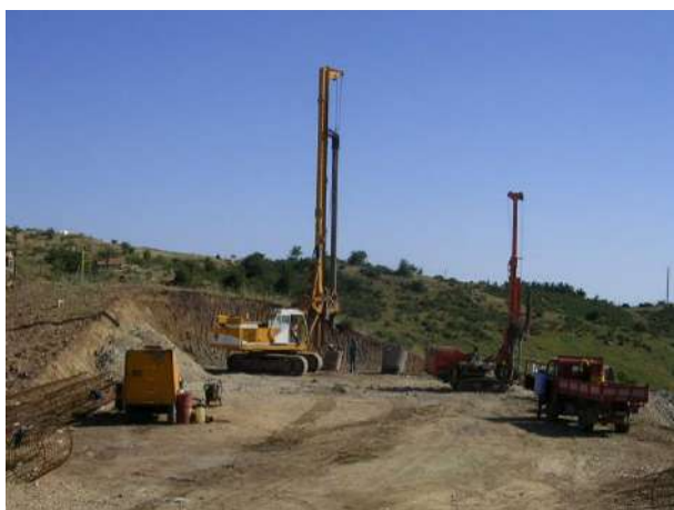
Realizzazione pali trivellati
