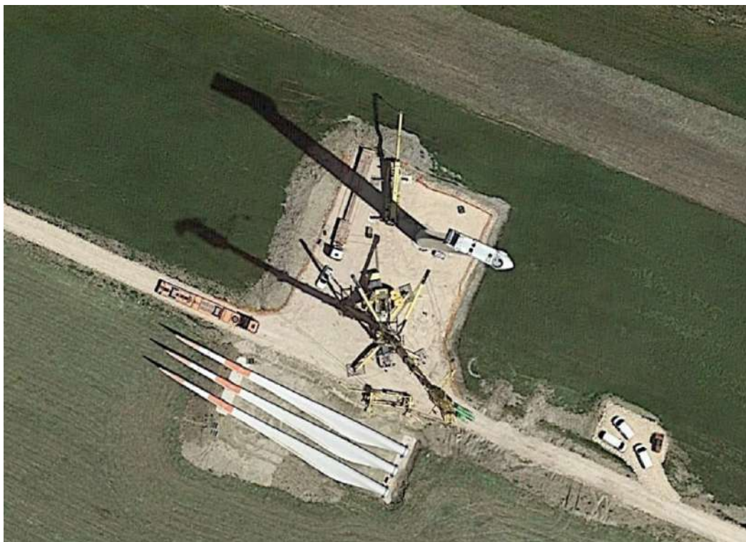
Figura 4.10: esempio di piazzola in fase di costruzione
