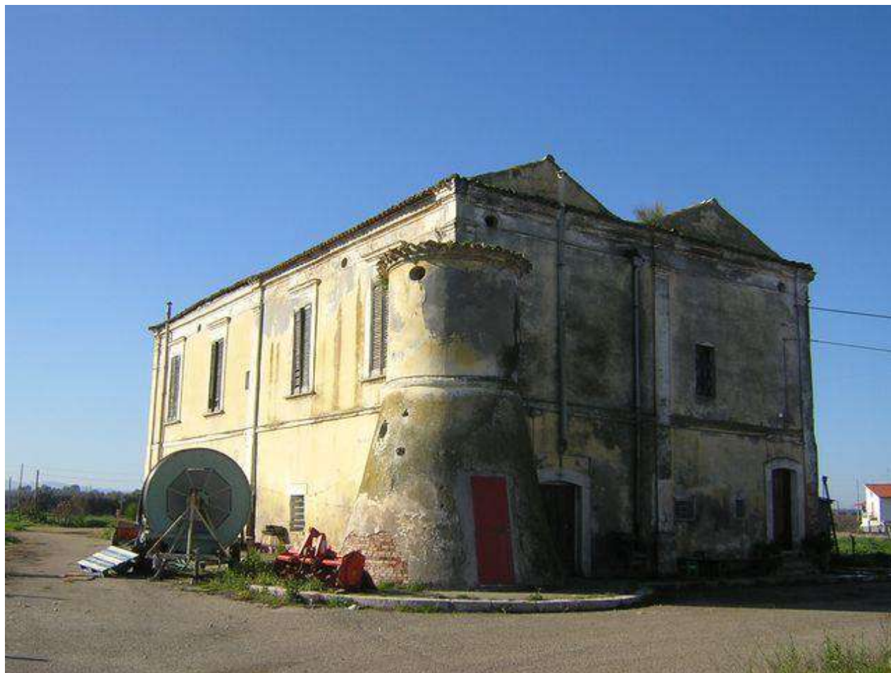
Figura 6.112: Vista esterna della Masseria Fortificata Ramitelli
