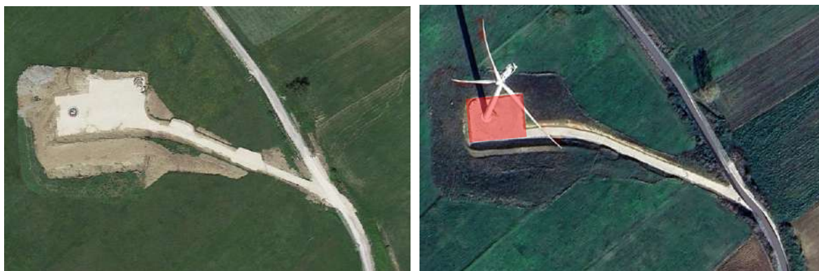
Piazzola in fase di cantiere
