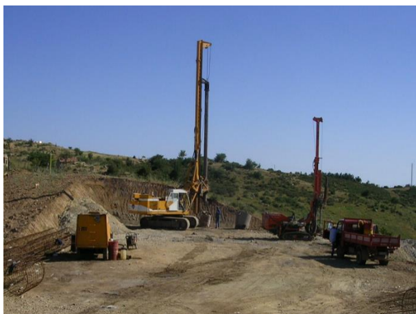
Realizzazione pali trivellati
