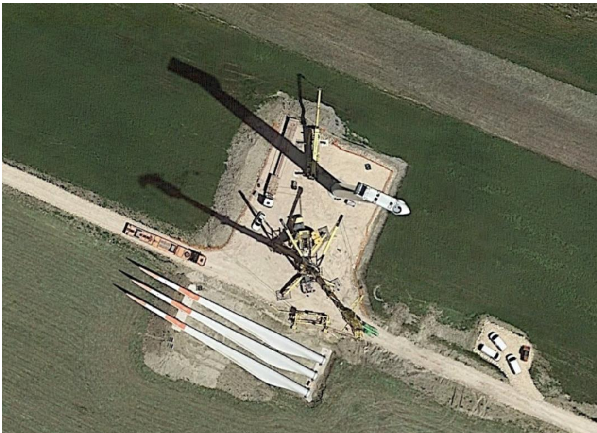
Figura 3.8: Esempio di piazzola in fase di costruzione
