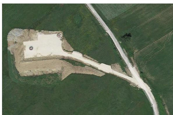
Piazzola in fase di cantiere
