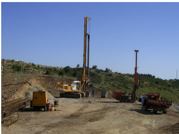
Realizzazione pali trivellati
