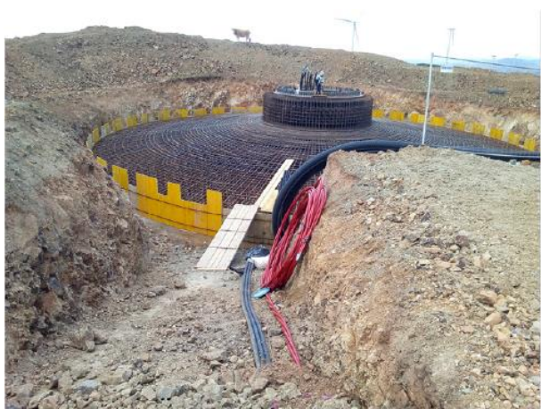
Posa ferri e cassetatura
