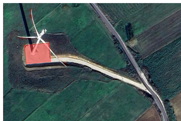
Piazzola in fase di esercizio
