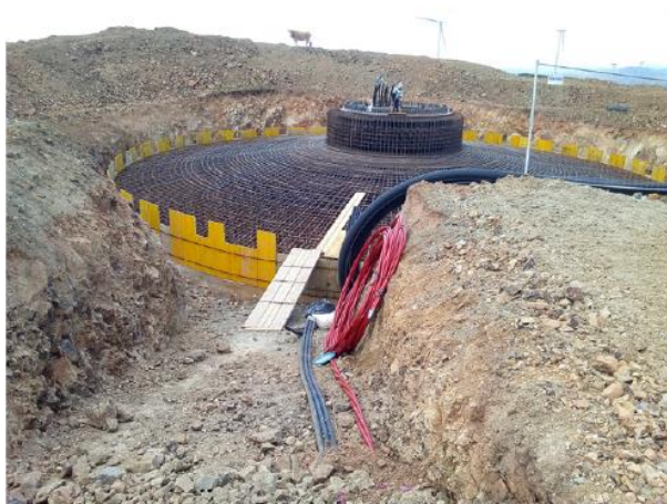
Posa ferri e cassetatura
