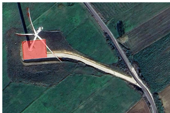
Piazzola in fase di esercizio
