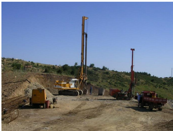
Realizzazione pali trivellati
