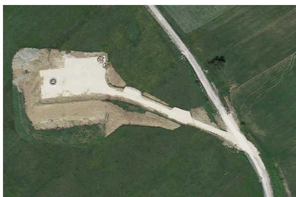
Piazzola in fase di cantiere
