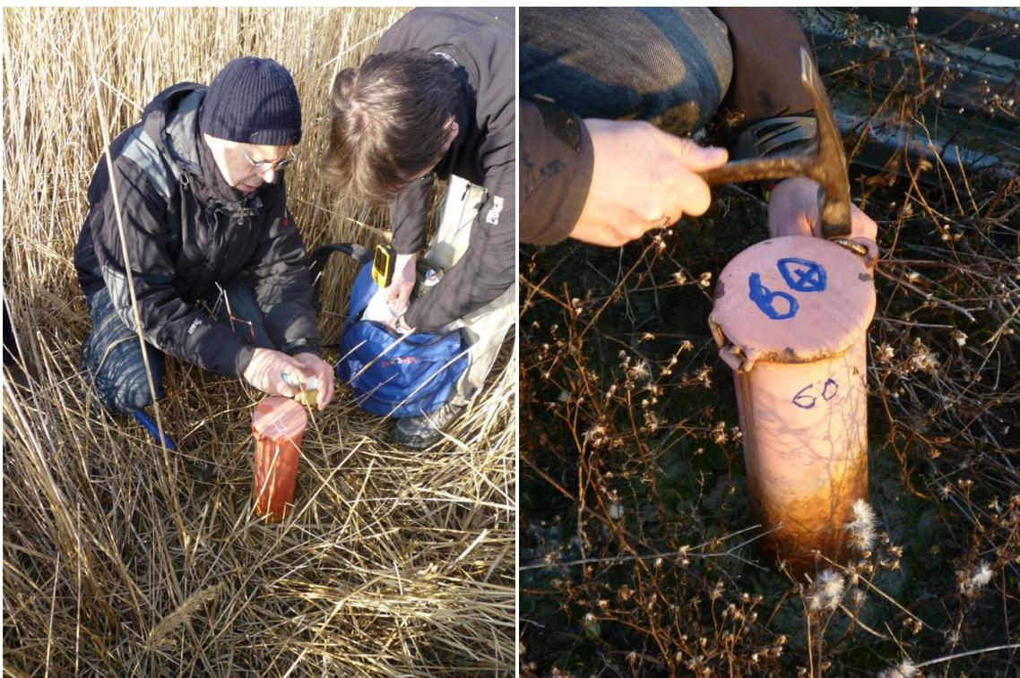
*Fig. 2.1-2 - Operazioni di apertura e ripristino dei pozzetti di accesso ai piezometri*
