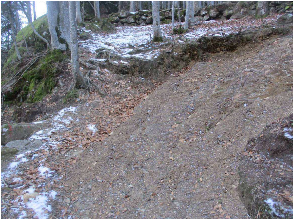
Fotosimulazione che rappresenta il tratto medio del sentiero in seguito a parziale rettifica e livellamento del piano viabile
