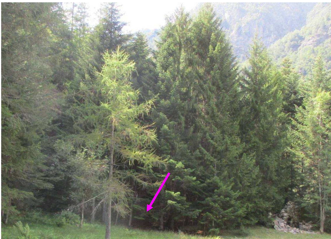
Foto 4: zona di posizionamento della perforatrice con relativa piattaforma temporanea di appoggio in cls
