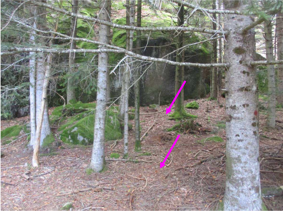
Foto 1: zona di posizionamento della perforatrice con relativa piattaforma temporanea di appoggio in cls
