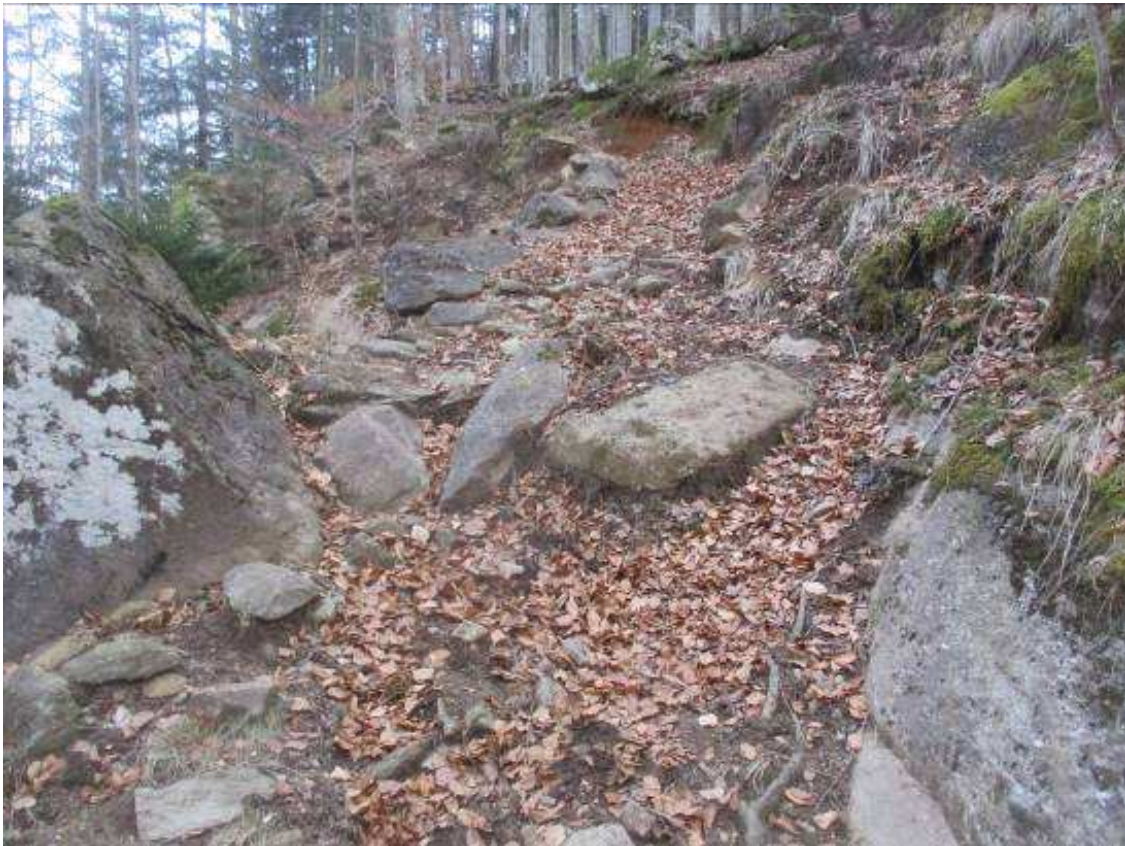
Foto 32: Tratto medio-inferiore del sentiero che si prevede di adeguare con parziale rettifica e livellamento del piano viabile
