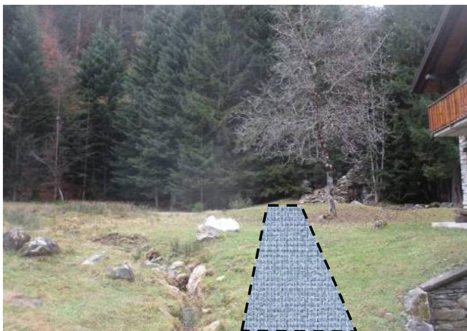
**FIGURA 85-POSIZIONAMENTO TAPPETO PROTETTIVO IN SIMIL-GOMMA O HDPE.**
