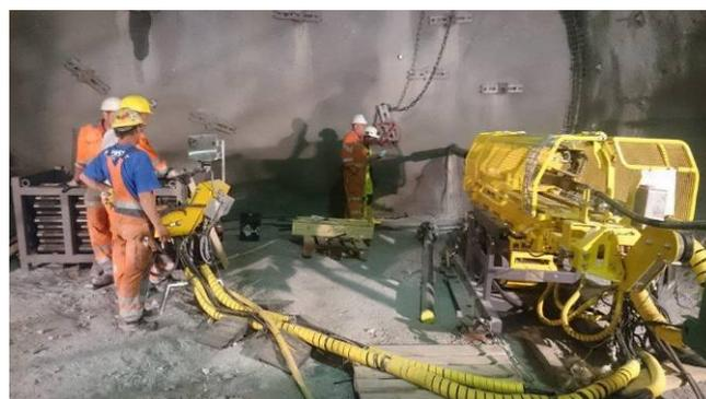
**FIGURA 32-SONDA EPIROC PCH6 IN ALLESTIMENTO PER SOTTERRANEO IN DIVERSE PROSPETTIVE. L'AREA DI INGOMBRO IN ESTERNO È ANALOGA.**
