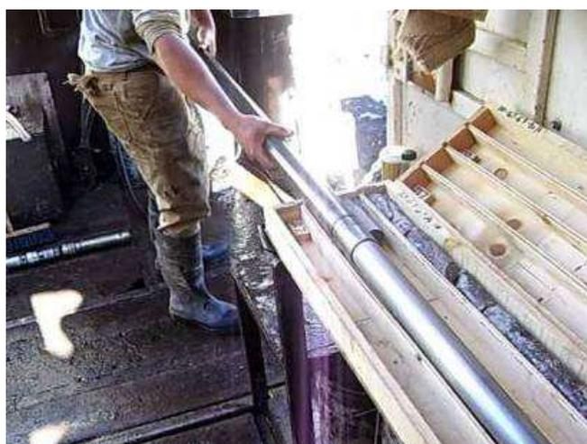
FIGURA 37-ESEMPIO DI ESTRAZIONE DI UNA CAROTA DAL CAROTIERE.
