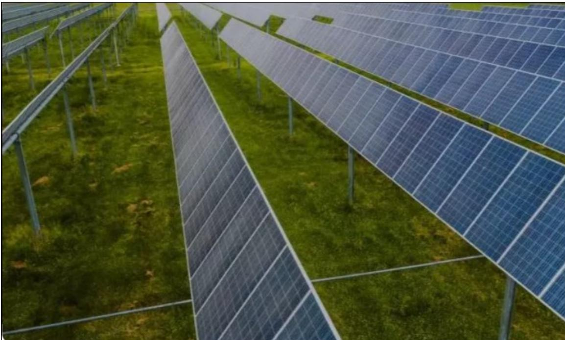
*Figura 6.5: campo fotovoltaico su inseguitori mono assiali con singolo modulo*
