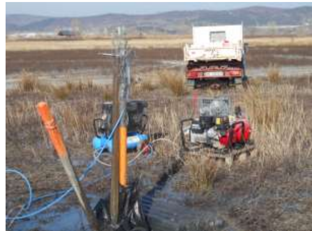
FASI DI PULIZIA DEL PIEZOMETRO PZ60
