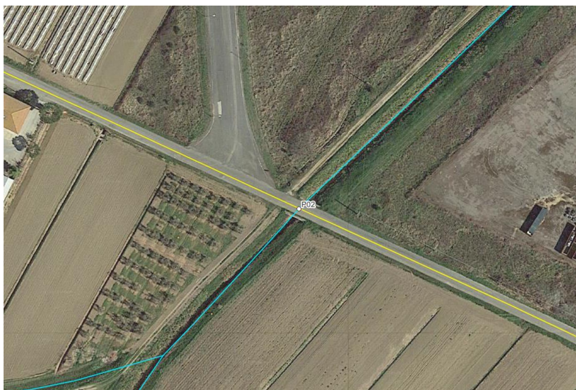
Figura 6.39: Ubicazione su ortofoto dell'interferenza P02, in giallo il tracciato del cavidotto di interconnessione, in azzurro il reticolo idrico
