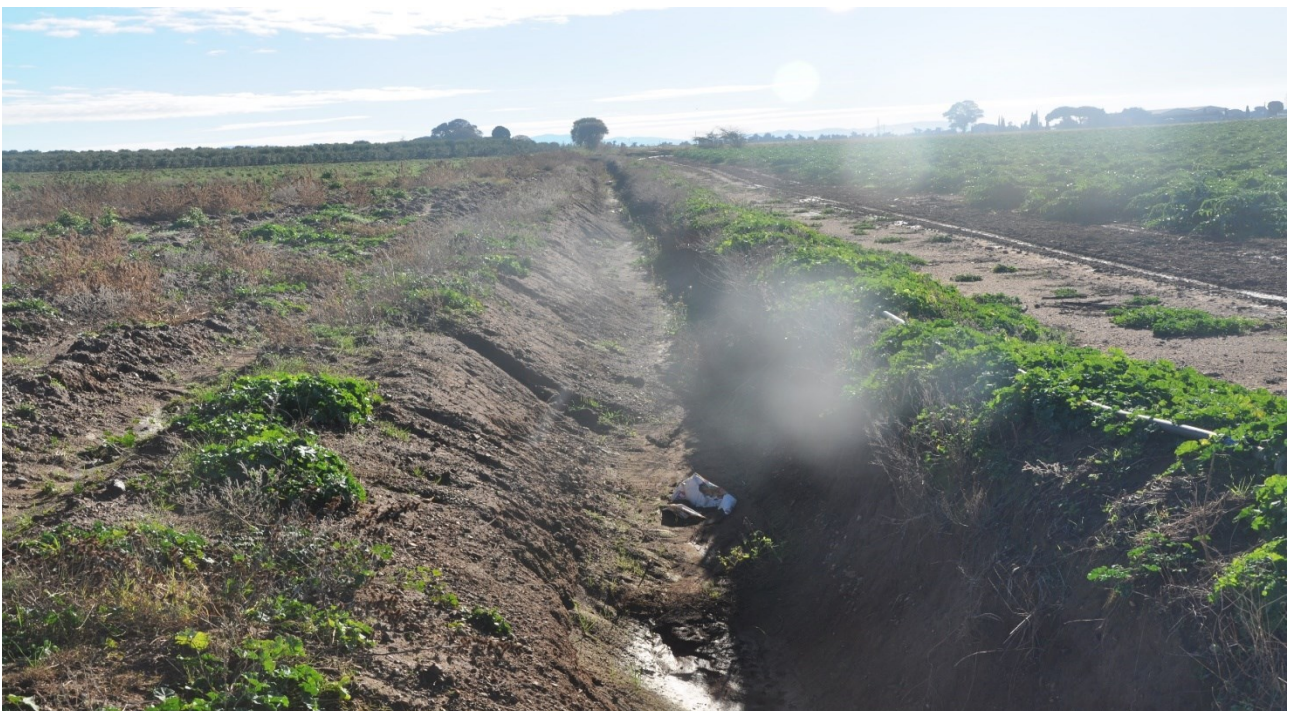
Figura 20– Sistema di regimazione delle acque in eccesso con collettori comuni a confine con il Campo A
