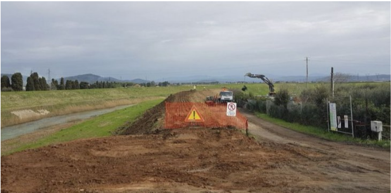
Figura 18– Argine artificiale del fiume Cornia
