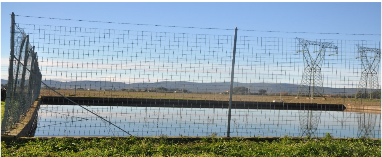
Figura 22– Vasca aziendale di accumulo
