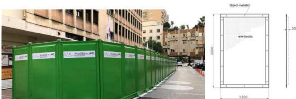
**Figura 22 – Caratteristiche esemplificative di una barriera antirumore temporanea**
