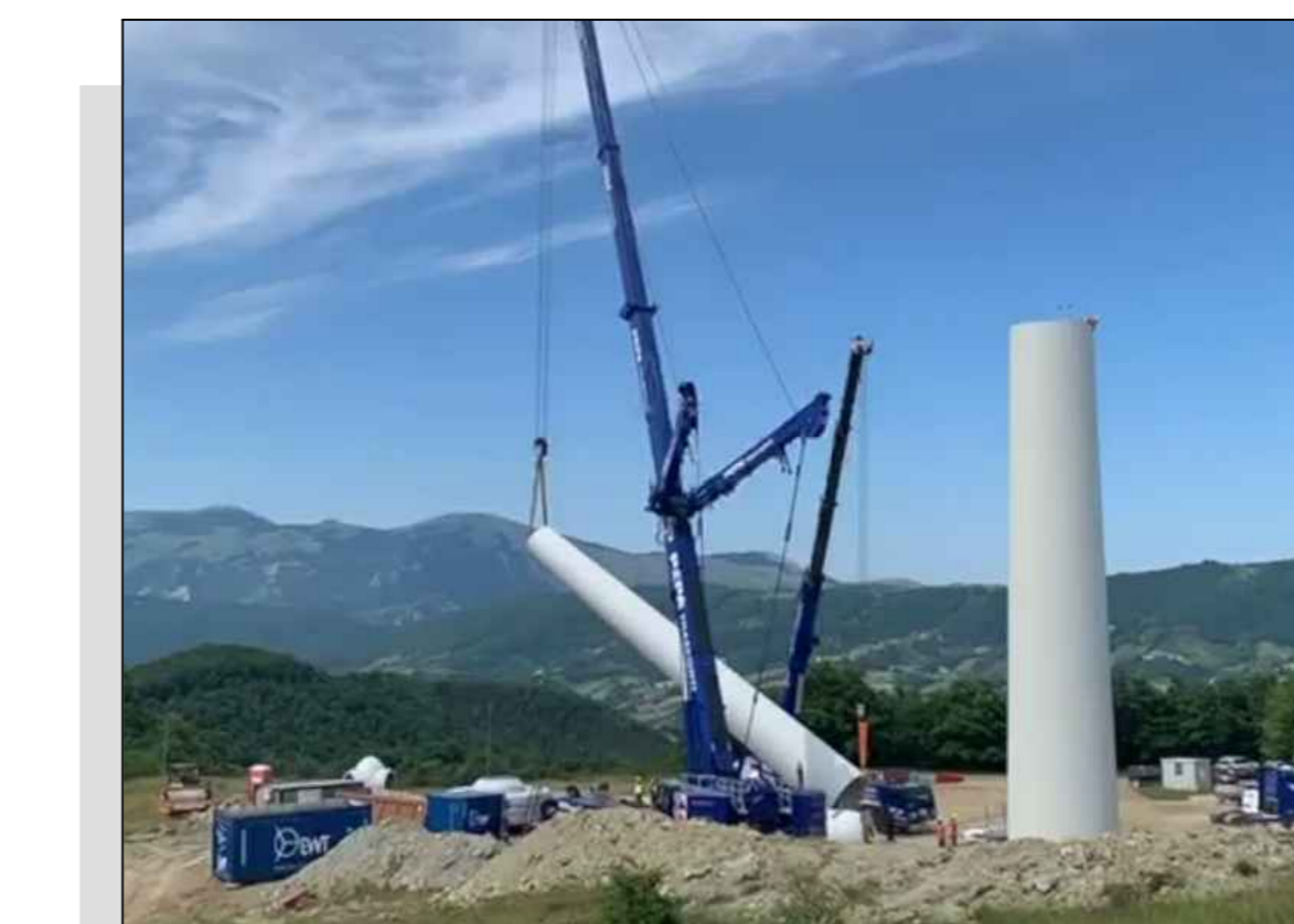
Piazzola di montaggio - fase di montaggio
