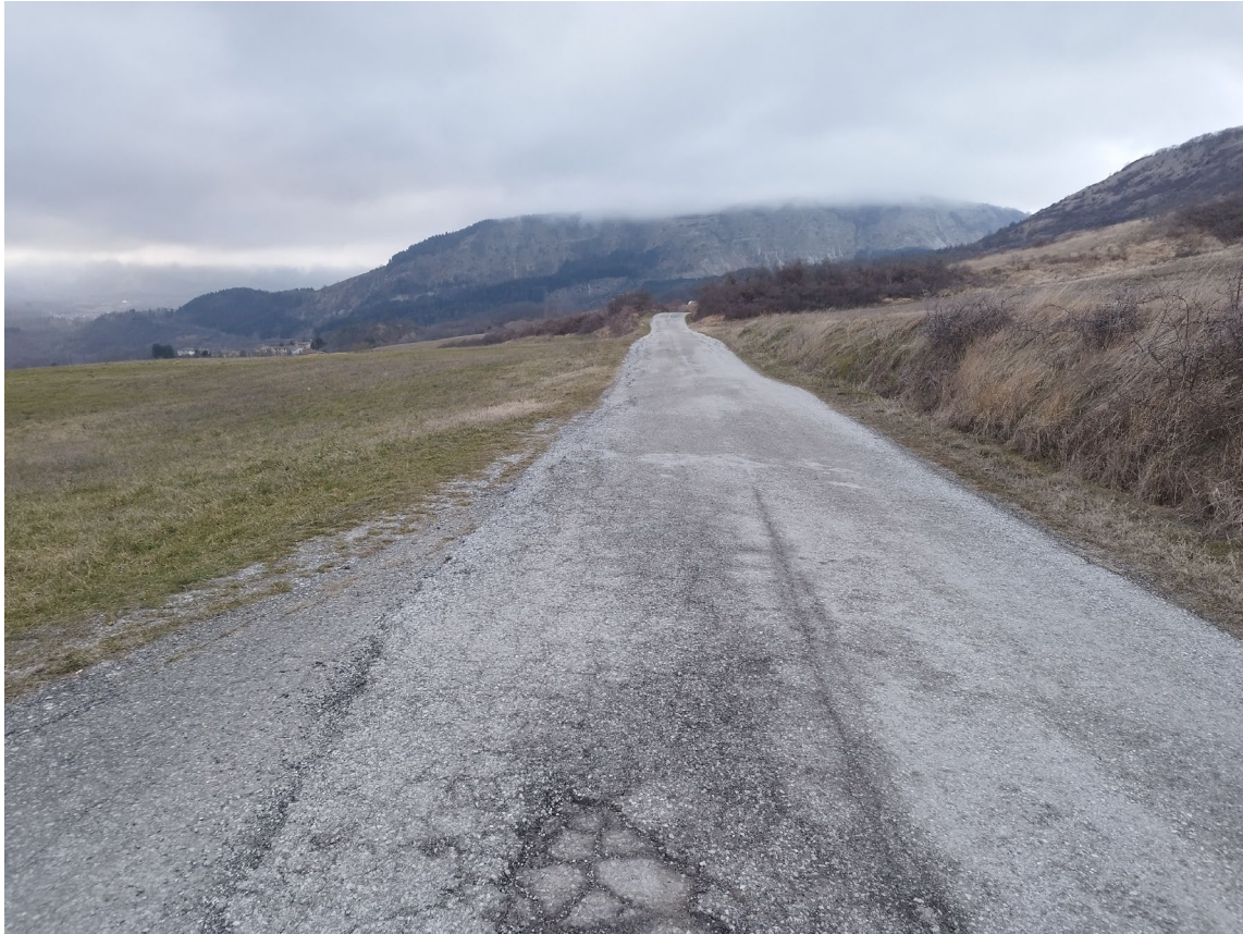
Viabilità in conglomerato bituminoso esistente in discreto stato
