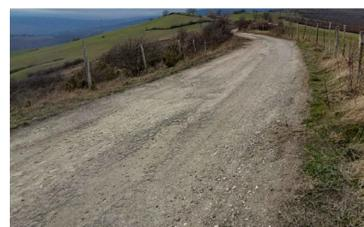
**TIPOLOGIA 22: Viabilità esistente con pavimentazione naturale in pessimo stato**
