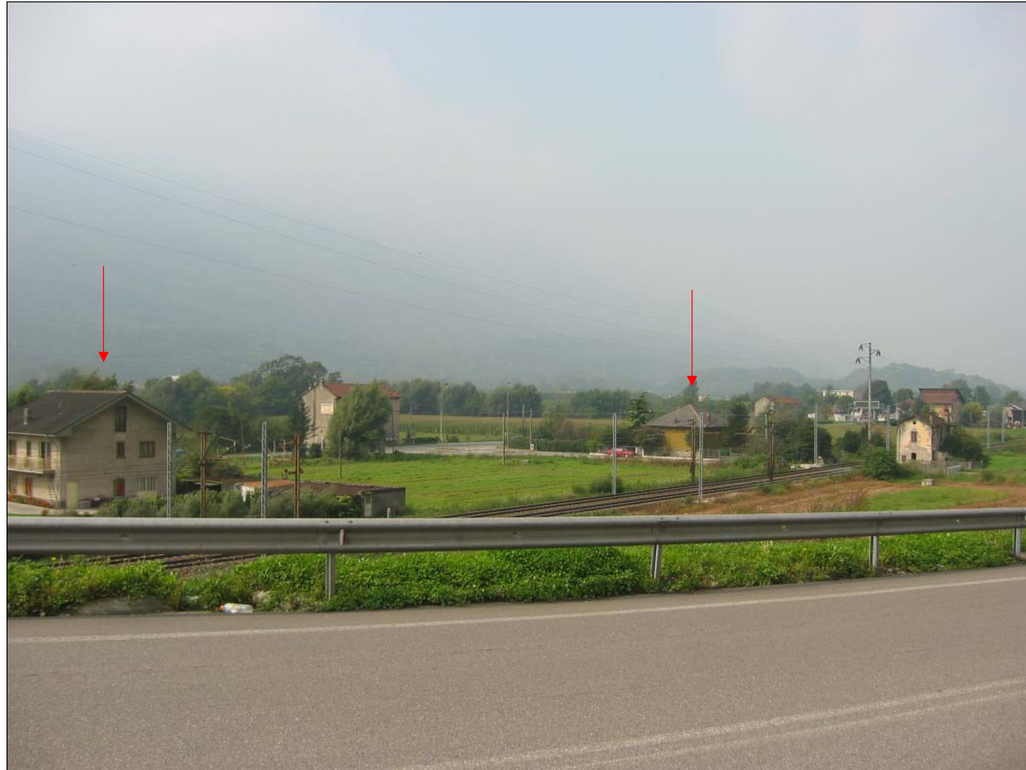
Gli edifici da demolire lungo la SS 25 in corrispondenza dell'acciaieria
