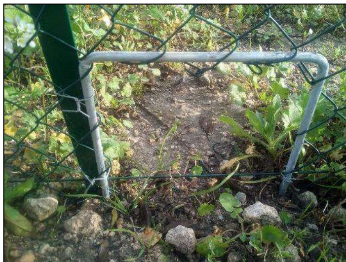
Particolare dei passaggi fauna
