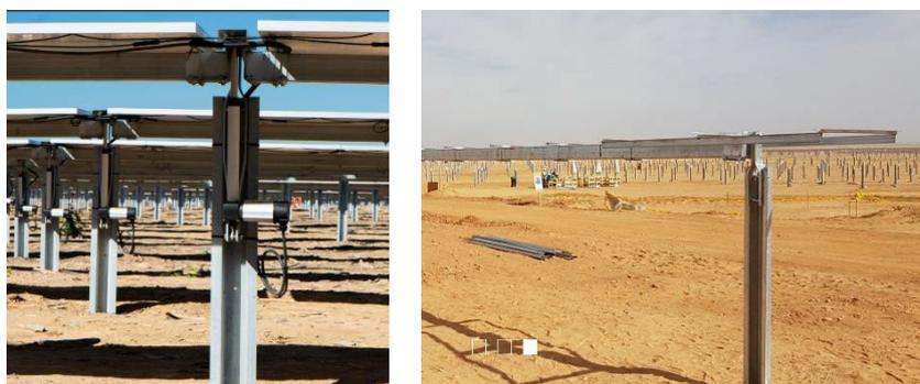
Figura 5 - Particolare strutture ad inseguimento ed attuatore
