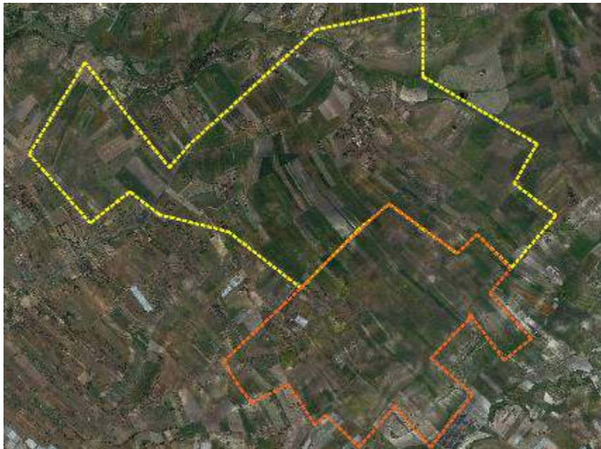
Figura 1 – Individuazione campi fotovoltaici: "Caltagirone I" (contornato in giallo) e "Caltagirone II" (contornato in arancione)
