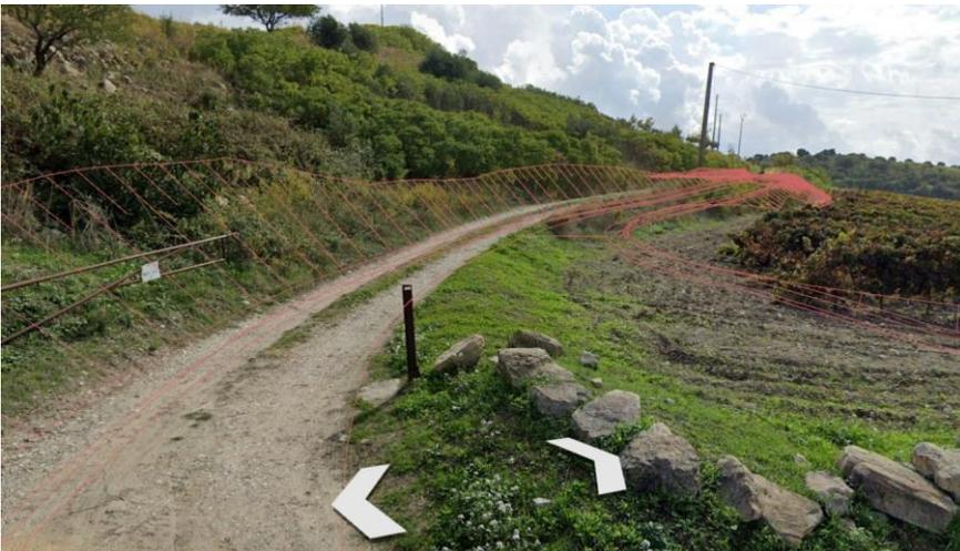
**Asse 07\_AD:** Trattasi dell'adeguamento di un tracciato esistente che dalla SP 70 conduce in prossimità del sito di installazione dell'aerogeneratore S16.
