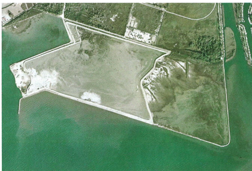
L'area della cassa di colmata in un'immagine ortofoto del 2003
