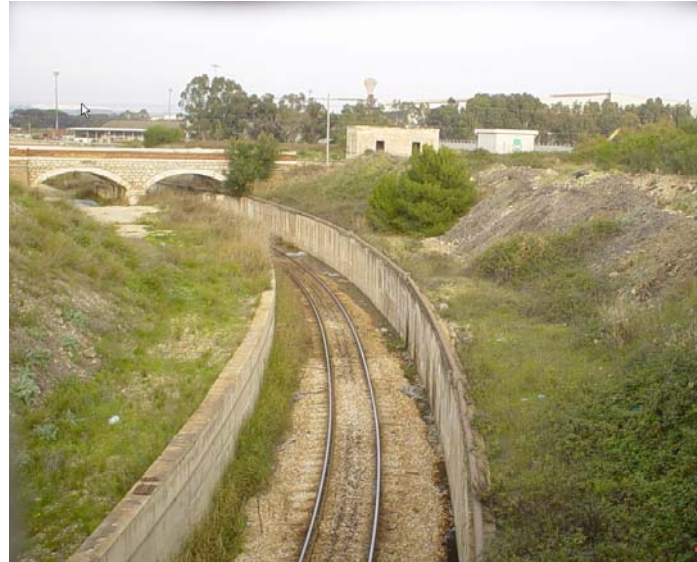
Foto 3.2.2 Vista sul binario ILVA
