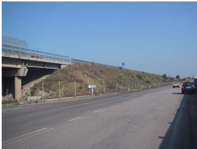
Foto 5.5.4 Rilevato della S.S. Jonica
