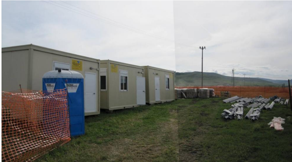
Foto 2 - esempio di area centrale di cantiere
