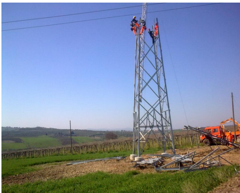
Foto 1 - area di microcantiere tipo per l'installazione di un sostegno 150 kV
