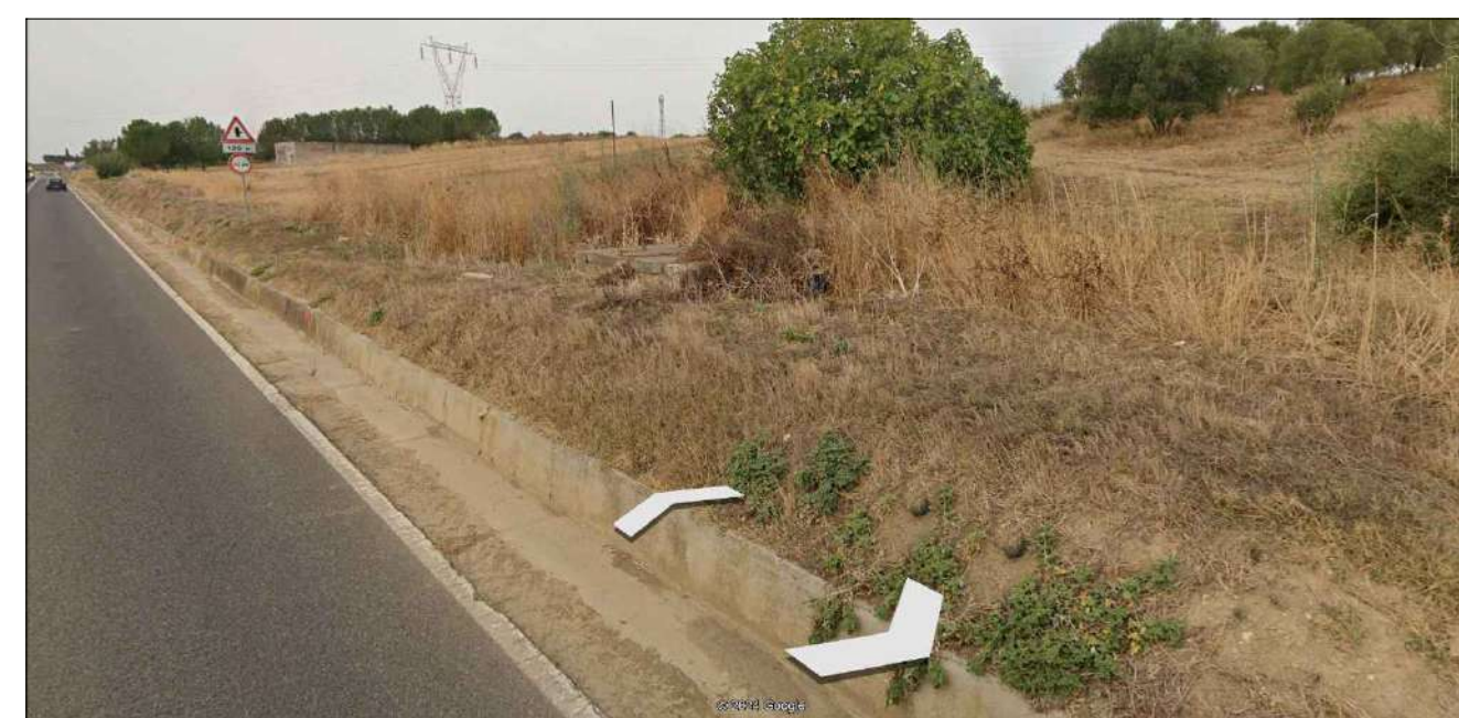
STATO DEI LUOGHI, VISTA STRADA - INTERFERENZA 04
