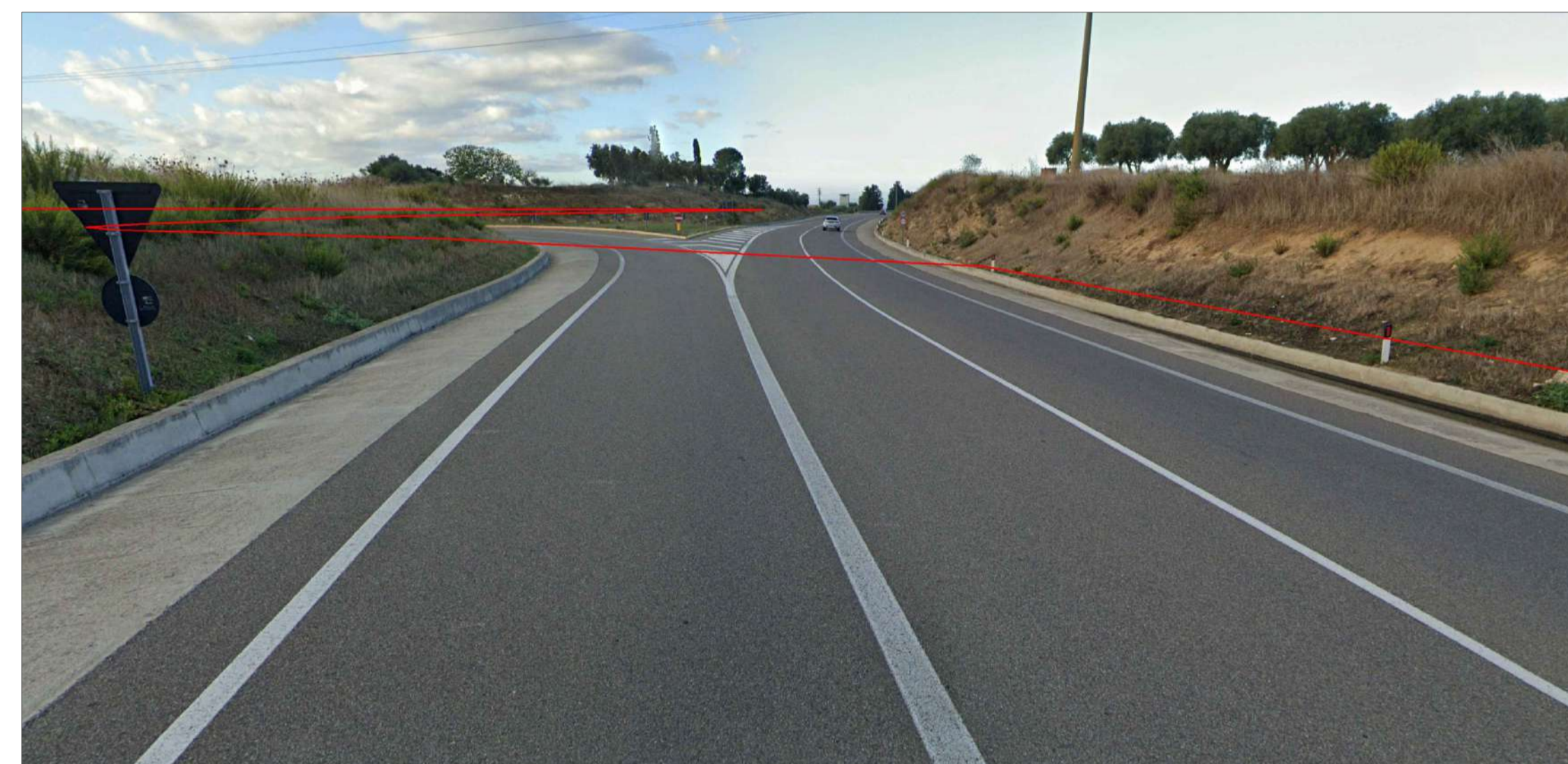
STATO DEI LUOGHI, VISTA STRADA - ATTRAVERSAMENTO STRADALE 02
