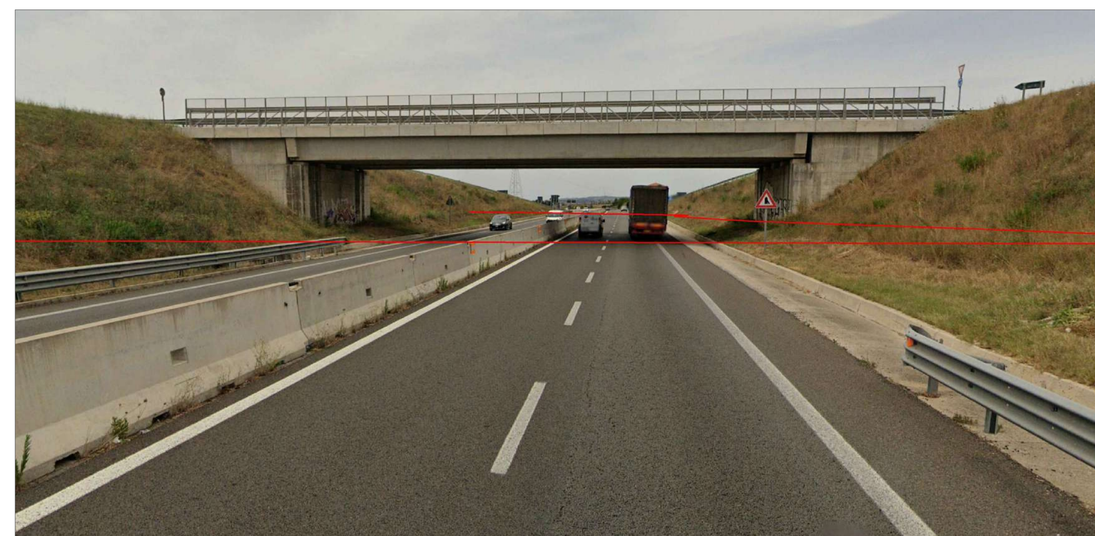
STATO DEI LUOGHI, VISTA STRADA - ATTRAVERSAMENTO STRADALE 01
