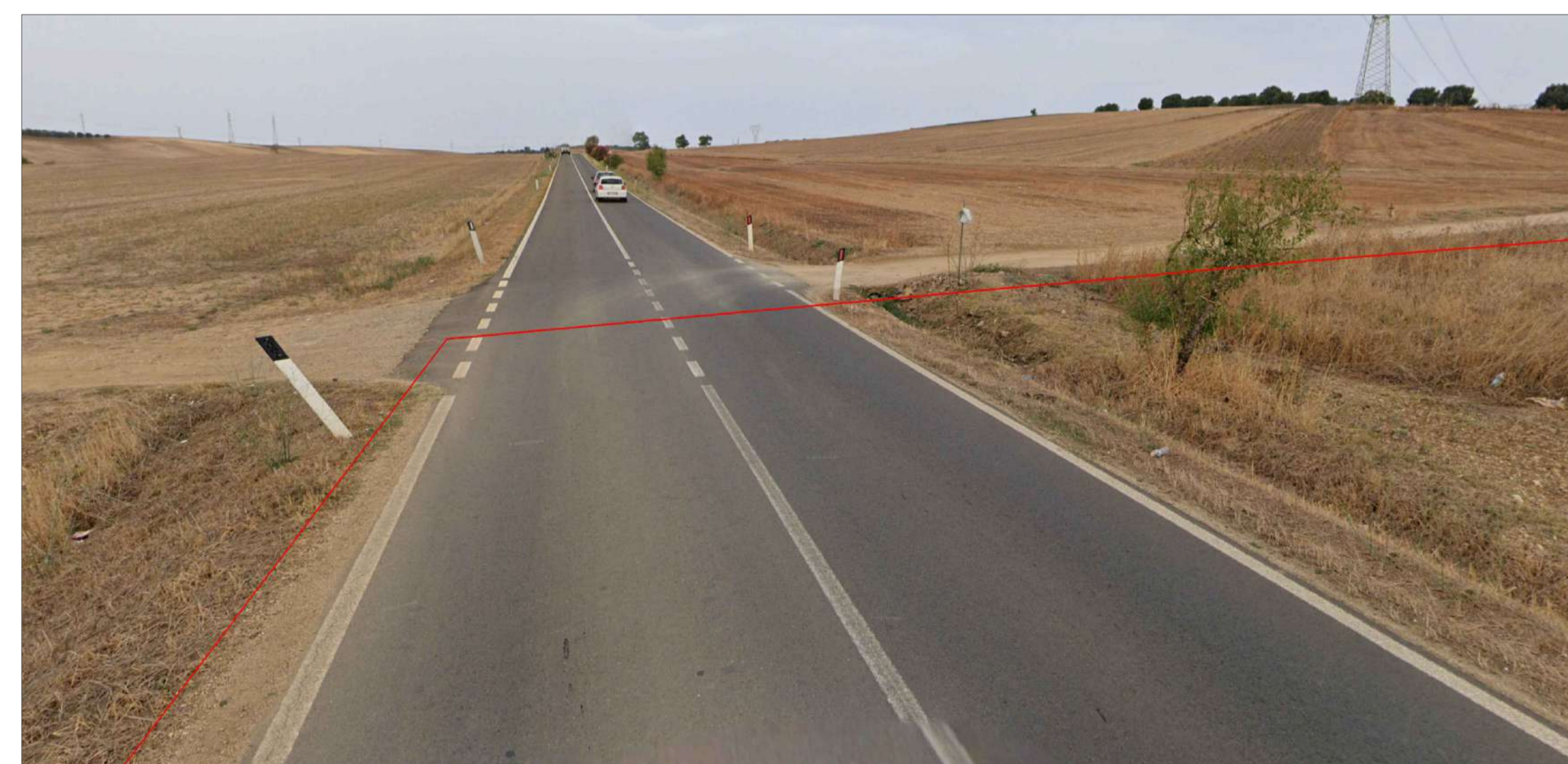
STATO DEI LUOGHI, VISTA STRADA - ATTRAVERSAMENTO STRADALE 03
