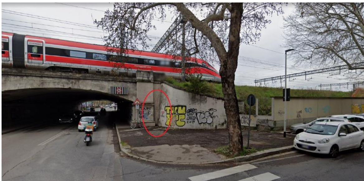
Figura 3- 8. Risalita cavo fibra ottica
