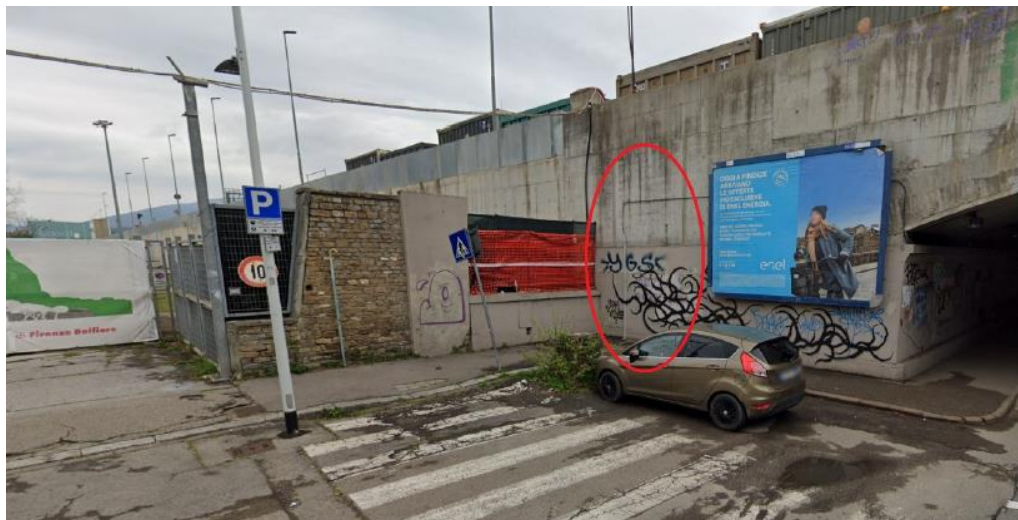
Figura 3- 7. Risalita cavo fibra ottica
