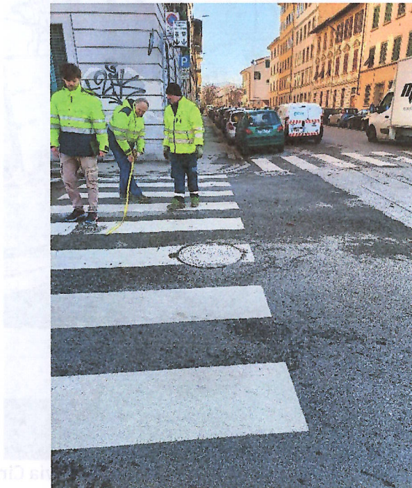
Foto 4. Tombino fognatura ovoidale cls 700x1050 – angolo via Circondaria/via Cironi
