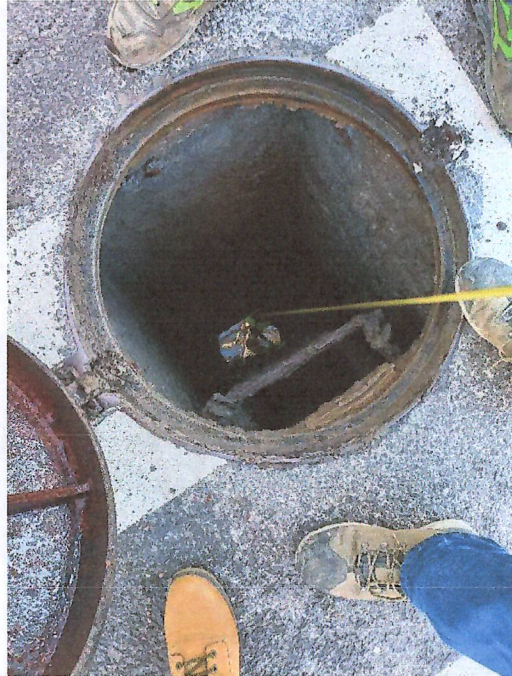
Foto 3. Fognatura ovoidale cls 700x1050 – angolo via Circondaria/via Cironi
