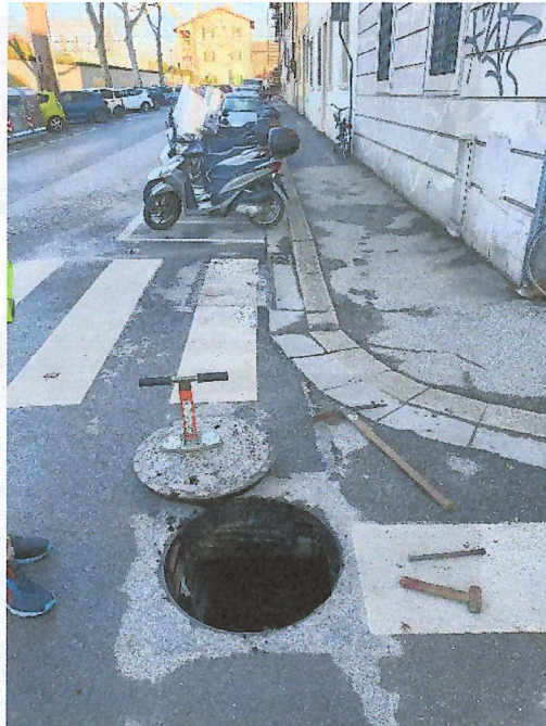
Foto 2. Tombino acquedotto in Ghisa DN 400 – angolo via Circondaria/via Cironi
