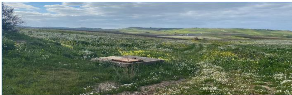
Figura 77 - Struttura pre-esistente per la derivazione dell'acqua dal laghetto in area centrale
