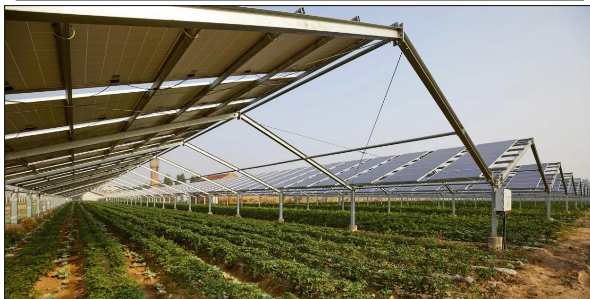
Figura 7.2. Agrovoltaico a moduli fissi con struttura a falde in Cina, in un campo a bacche di Goji
