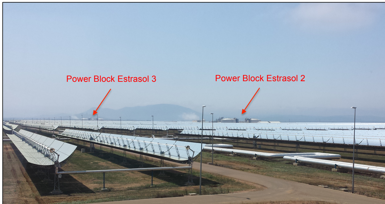
Figura 1: Impianto CSP Extresol ("Grupo Cobra" Spagna) - Vista delle Power Block degli impianti Estrasol 2 e 3 dalla Power Block dell'impianto Estrasol 1
