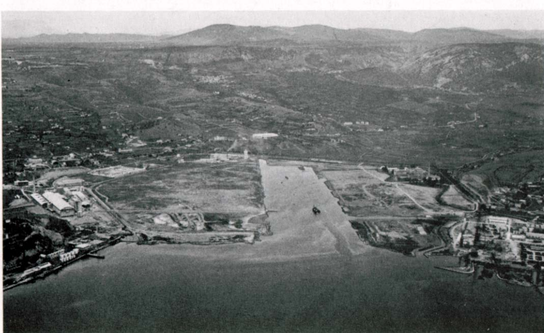
1954, agosto - Il canale pressoché ultimato - (A.E. - G.F.)
