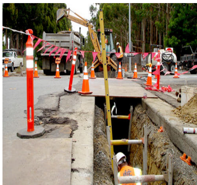
Fig. 4.2 – Esempi di fasi di cantiere per posa dei cavi interrati
