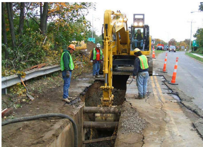
Fig.4.3 – Esempio di scavo di trincea
