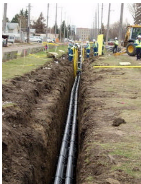
Fig. 4.2 – Esempi di fasi di cantiere per posa dei cavi interrati
