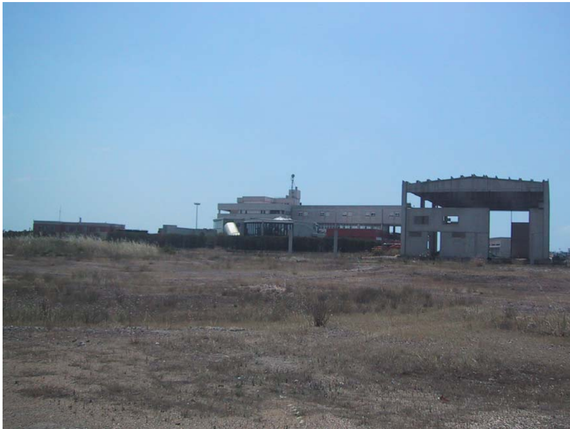
Foto 9 Area di localizzazione della rotatoria B. Vista da Nord. Edifici adibiti a uffici
