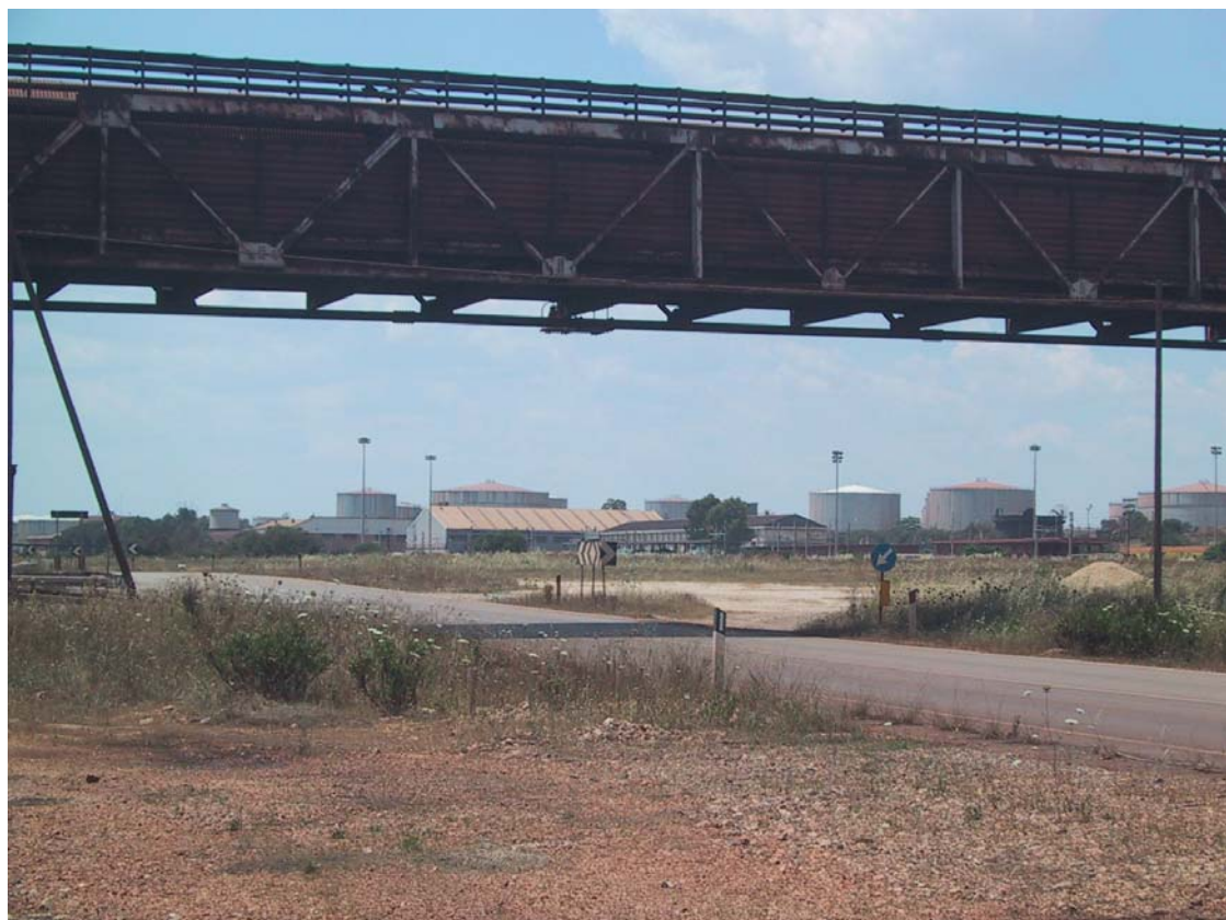
Foto 5 La strada e l'area di localizzazione della rotatoria A.
