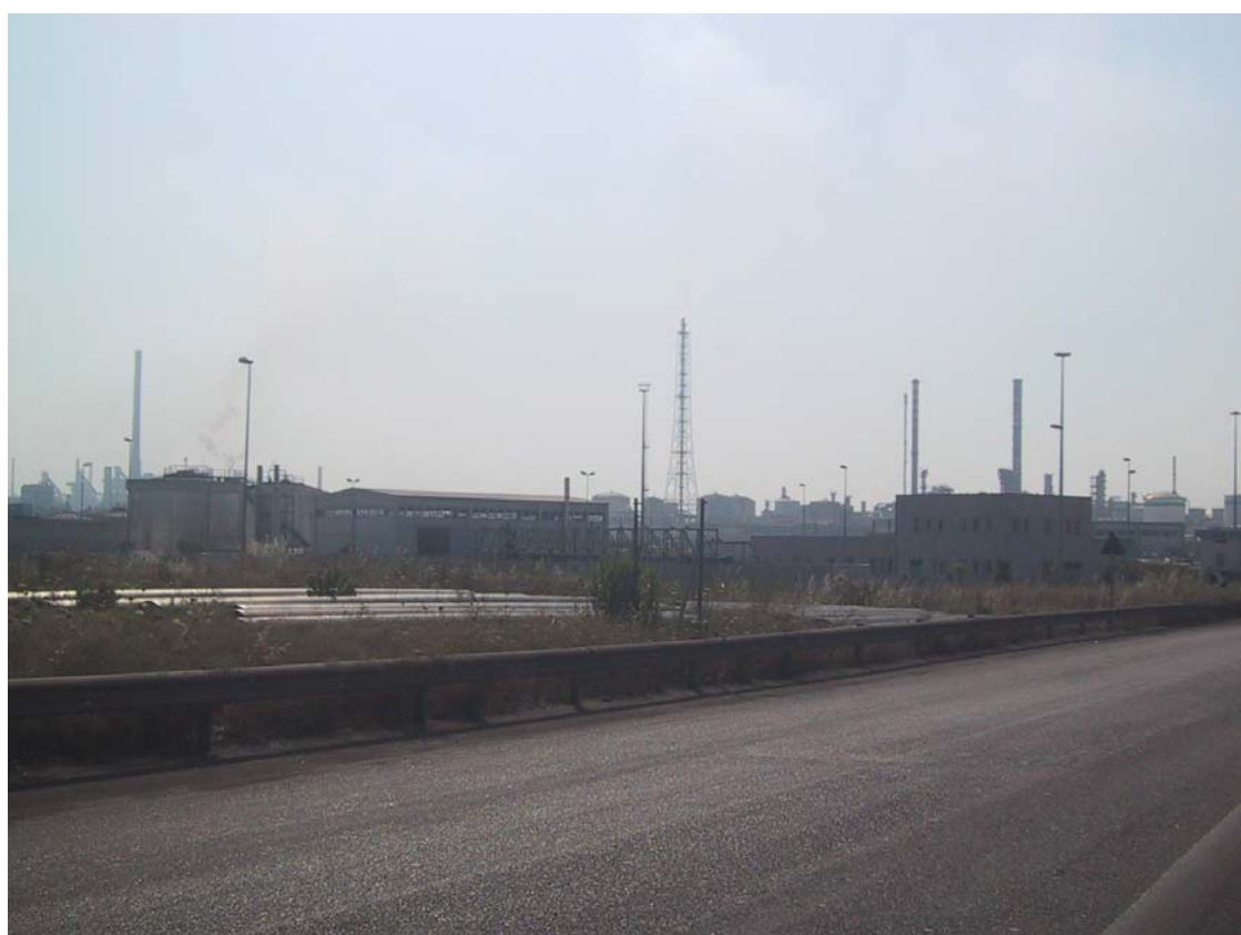
Foto 17 Impianto di depurazione
