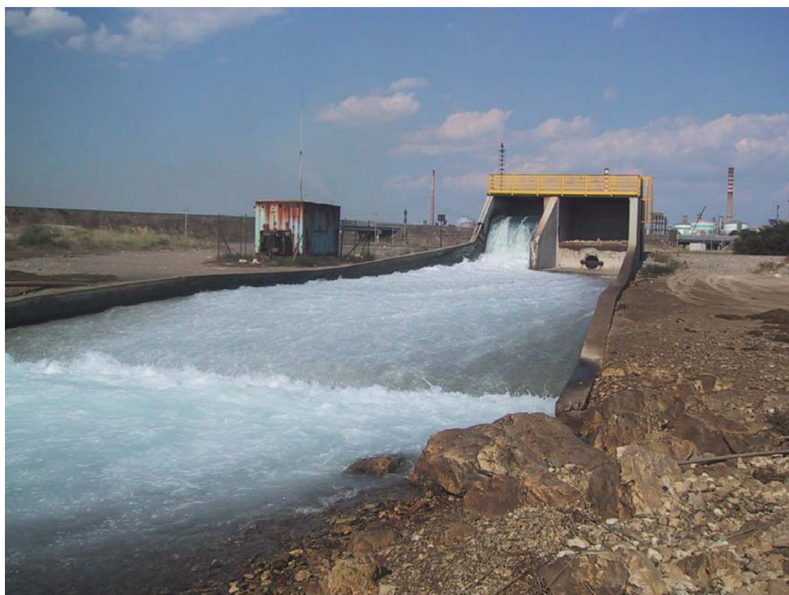
Foto 16 Il canale di scarico dell'ILVA
