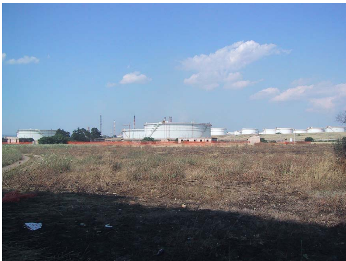
Foto 12 Area di localizzazione della rotatoria G. Sullo sfondo, gli impianti della AGIP PETROLI
