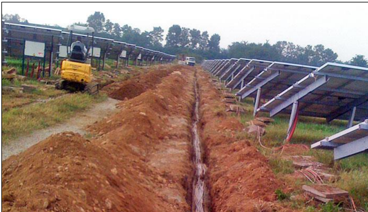
Figura 13 – Tipico di scavo per cavi in BT
