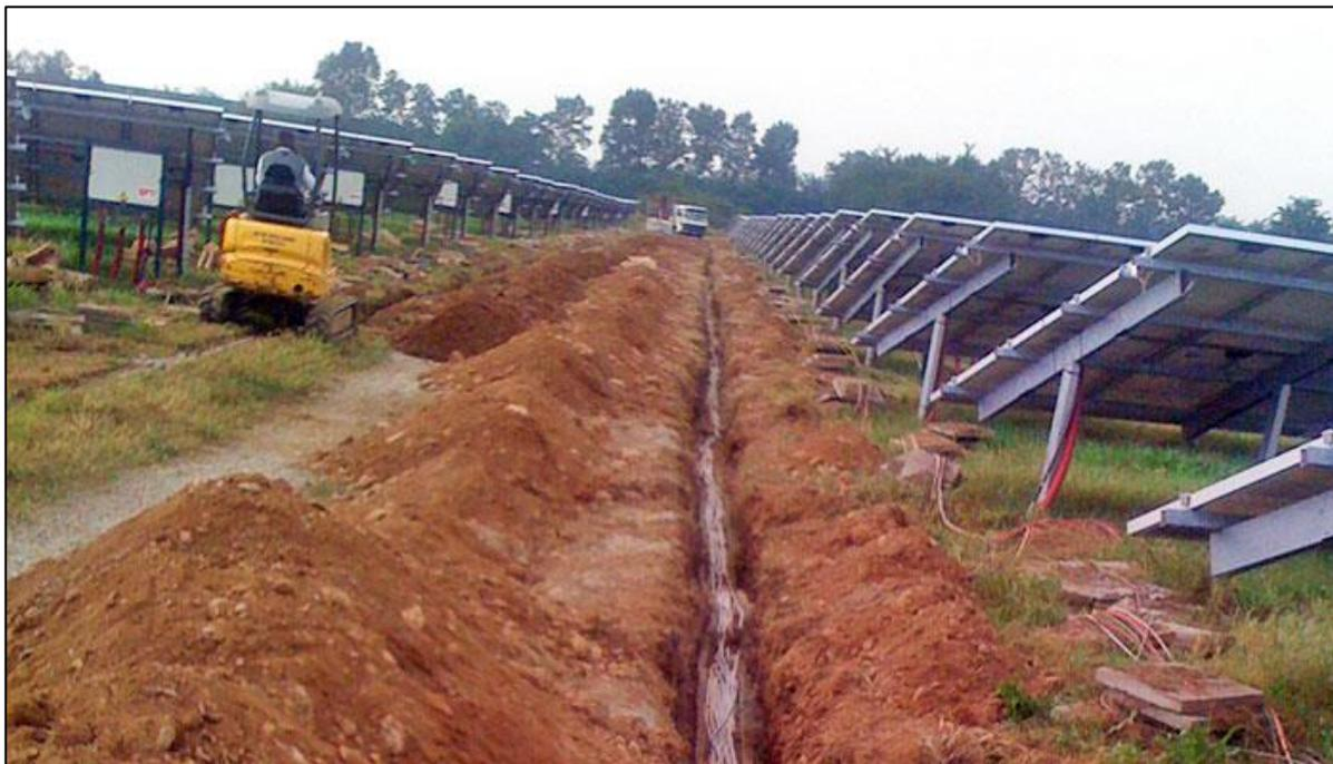
*Figura 13 – Tipico di scavo per cavi in BT*
