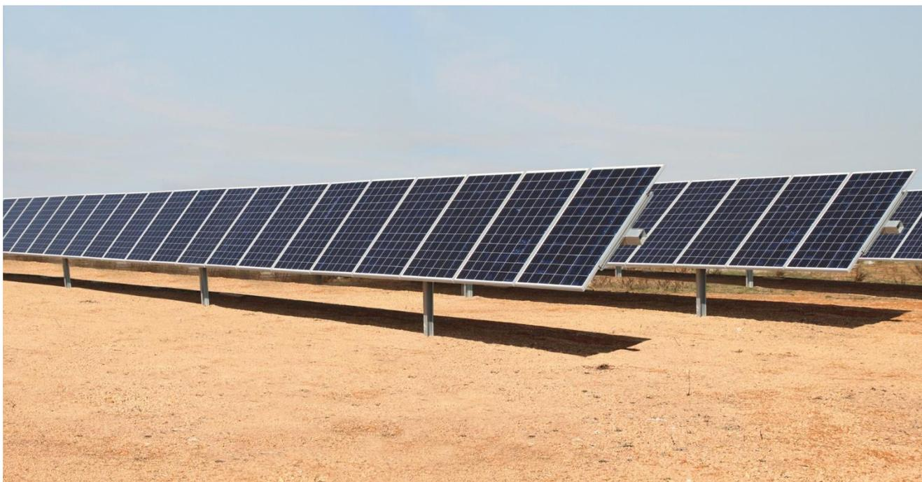
*Figura 10 – Strutture di sostegno dei moduli "tracker"*
