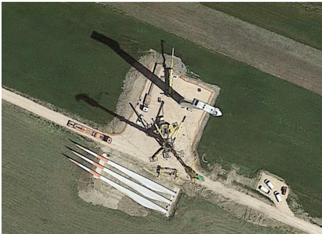
Figura 2.5: Esempio di piazzola in fase di costruzione
