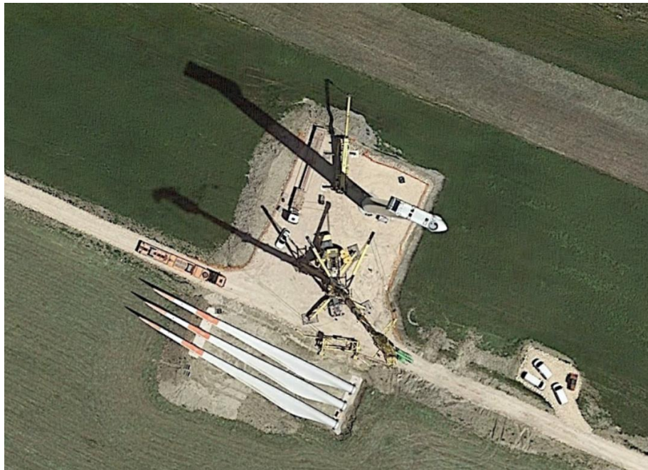
FIGURA 3.12 ESEMPIO PIAZZOLA IN COSTRUZIONE
