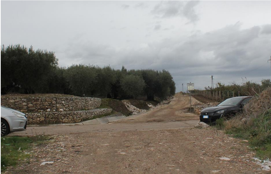
5 - Torremaggiore (FG) loc. Coppa la Vacca UR 1, panoramica in direzione NO dell'incrocio dei segmenti di cavidotti di connessione correnti su S.C. Torremaggiore-Lesina e strada interpoderale
