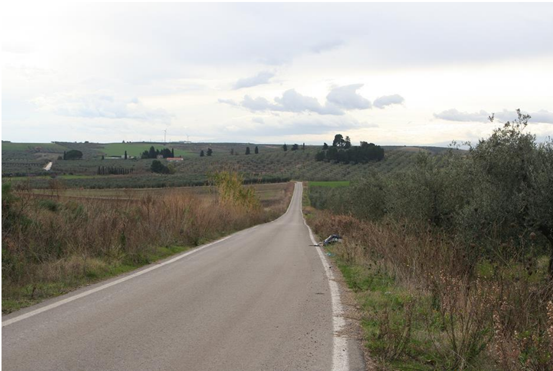
42 - San Paolo di Civitate (FG), UR 3 , segmento di cavidotto di connessione tra gli impianti WGT 02-01 corrente su s.c. senza nome, panoramica in direzione S
