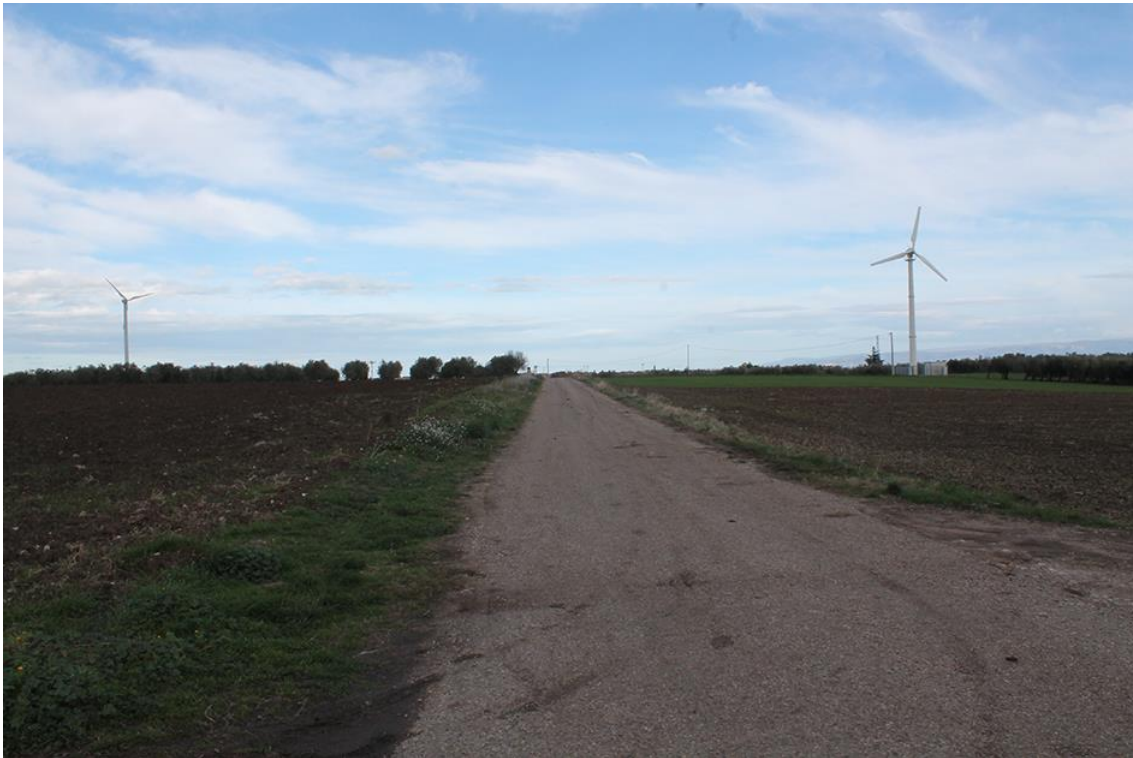
59 – San Paolo di Civitate (FG), loc. Mezzanella, UR 4 , segmento di cavidotto tra gli impianti WGT 03-04-07 corrente su s.c. Camerata, panoramica in direzione NE
