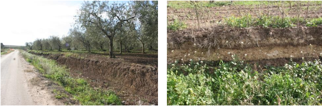
FIGURA 7.19 UR 5, IL TRACCIATO DELLA SP 46 LUNGO CUI DECORRE IL CAVIDOTTO È IN DIVERSI TRATTI FIANCHEGGIATO DA FOSSI SCAVATI AI BORDI DELLA STRADA
