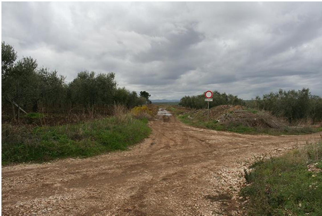
13 - Torremaggiore (FG) loc. Coppa la Breccia, UR 1, panoramica in direzione O del segmento di cavidotto di connessione WGT 11-10-06
