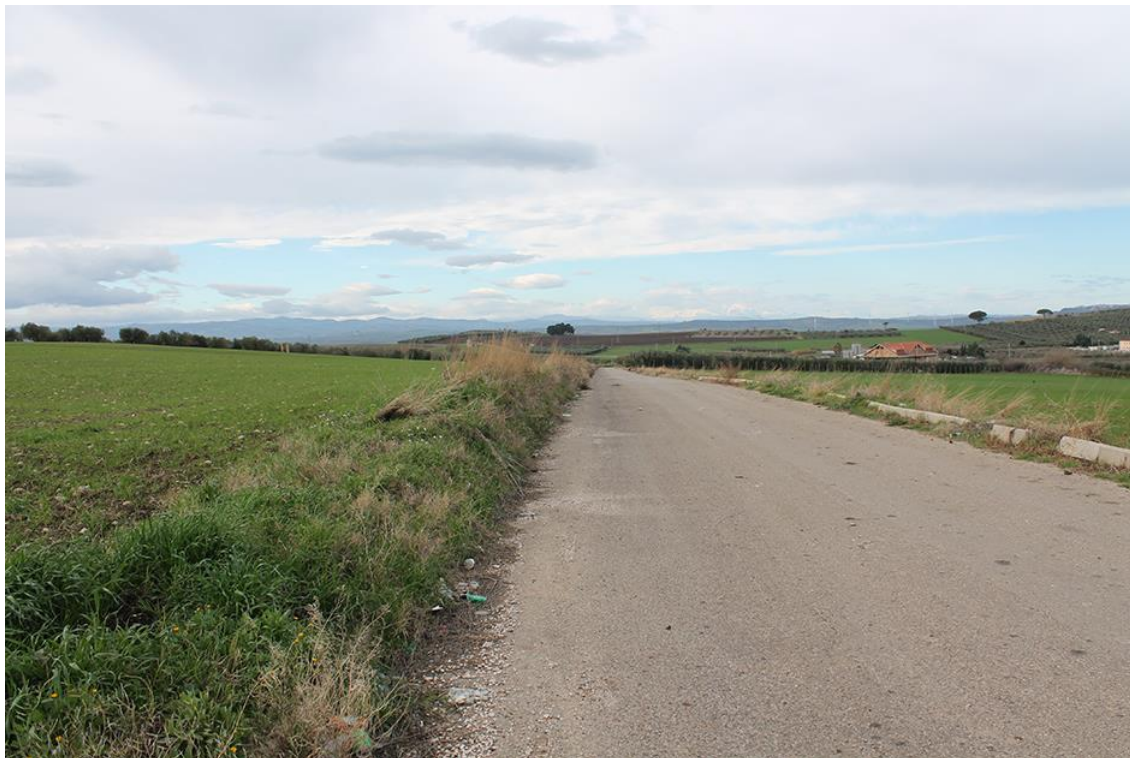
53 - San Paolo di Civitate (FG), loc. Mezzanella, UR 4 , segmento di cavidotto di connessione tra le UR 3 e UR 4, vista in direzione NO
