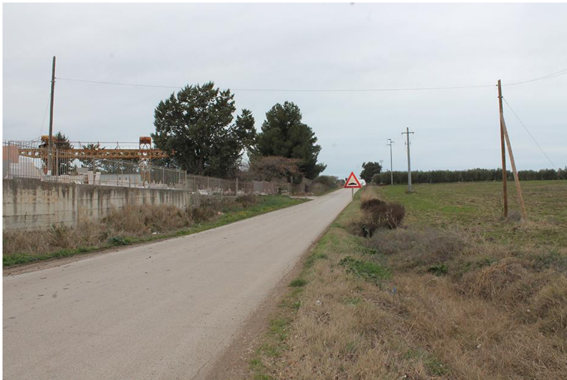
37 - San Paolo di Civitate (FG) loc. Mezzana, UR 3 , segmento di cavidotto di connessione tra gli impianti WGT 15, 01-02 corrente se SP 31, panoramica in direzione NO
