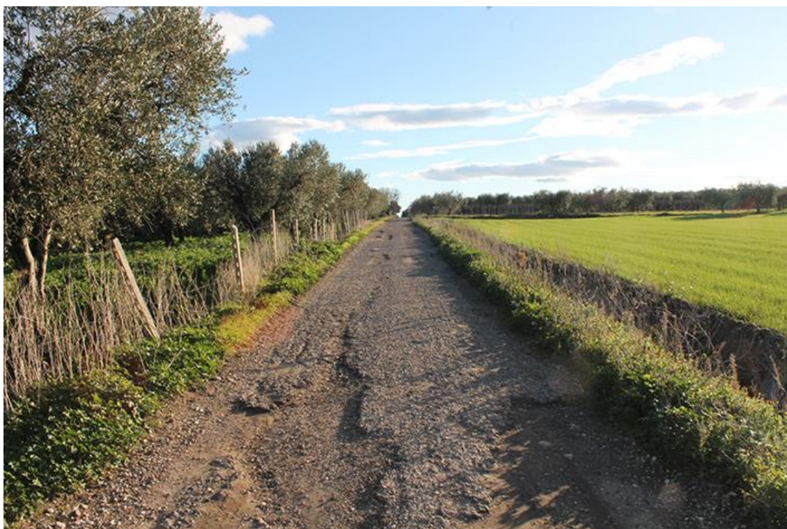
22 - San Paolo di Civitate (FG) loc. Cipolle, UR 2, segmento di cavidotto di connessione tra gli impianti WGT 13-14, 05, corrente su s.c. senza nome, panoramimca in direzione S
