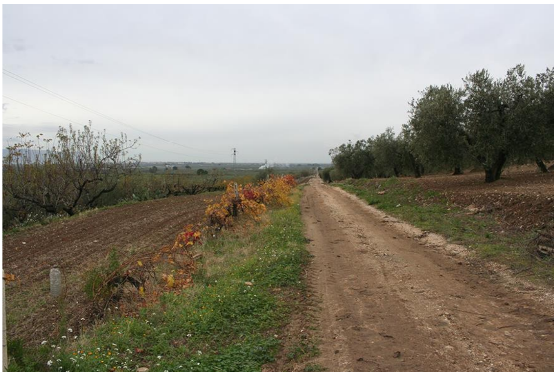
8 - Torremaggiore (FG) loc. Cappella, UR 1, panoramica in direzione E del segmento di cavidotto di connessione WGT 12-11-10-06
