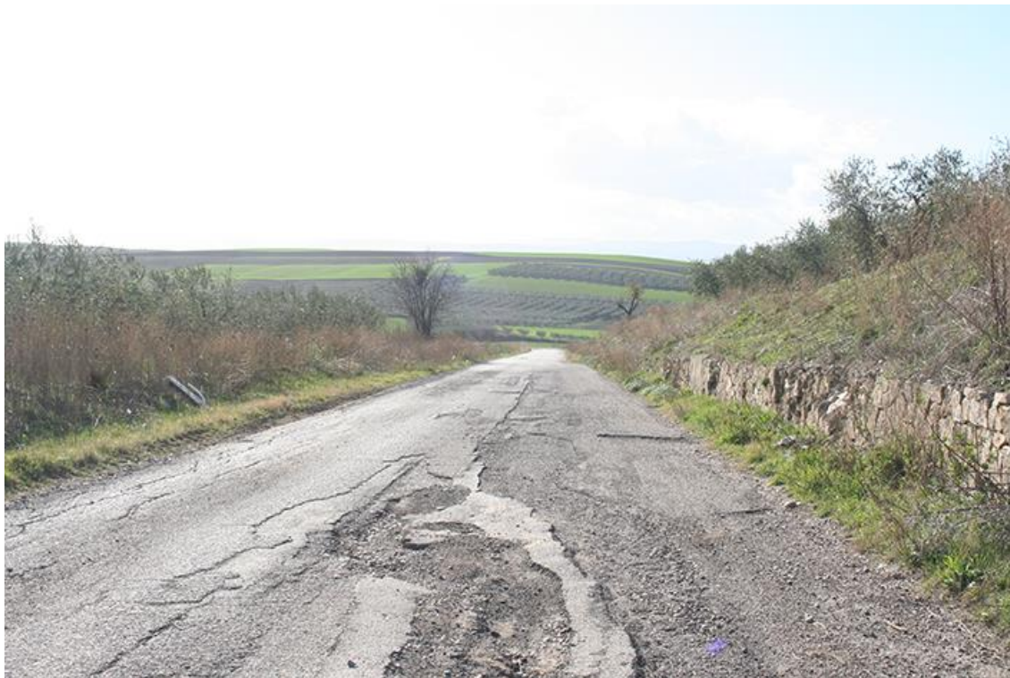
67 – San Paolo di Civitate (FG) loc. C. Ciaccia, UR 5, panoramica in direzione SO del segmento di cavidotto di connessione corrente su SP 46
