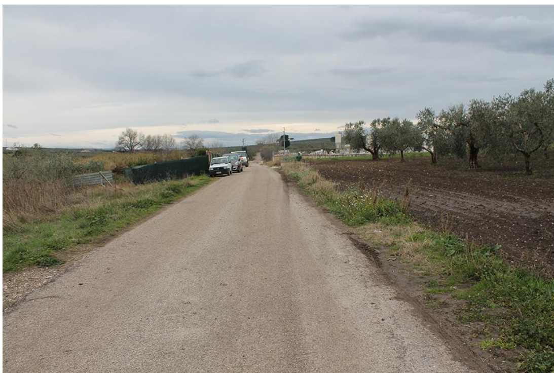
36 - San Paolo di Civitate (FG) loc. Mezzana, UR 3, segmento di cavidotto di connessione tra gli impianti WGT 15, 01-02 corrente se strada senza nome, panoramica in direzione O
