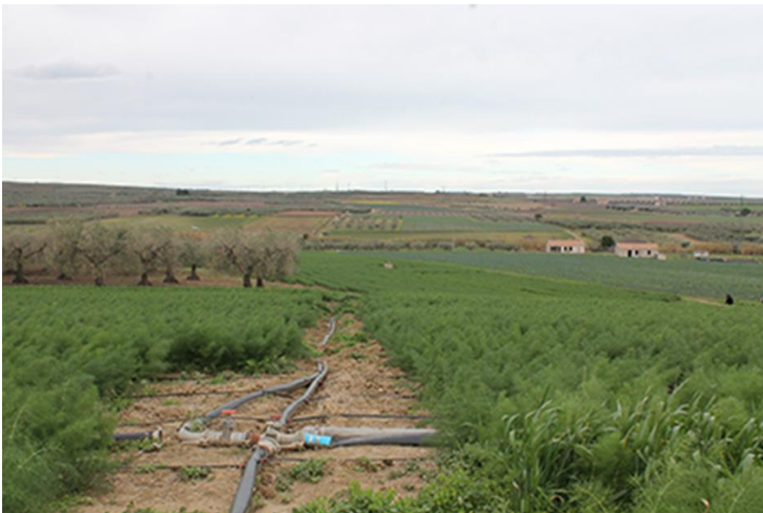
34 - San Paolo di Civitate (FG) loc. C.S. Raffaele, UR 3, panoramica in direzione NO del segmento di cavidotto di connessione all'impianto WGT 15
