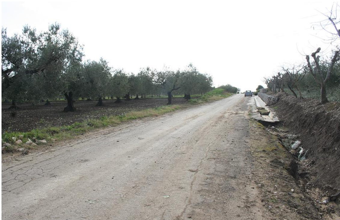
7 - Torremaggiore (FG) S.C. Torremaggiore - Lesina UR 1, panoramica in direzione S del segmento di cavidotto di connessione tra WGT 09 e UR 2(WGT 04, 013-014)
