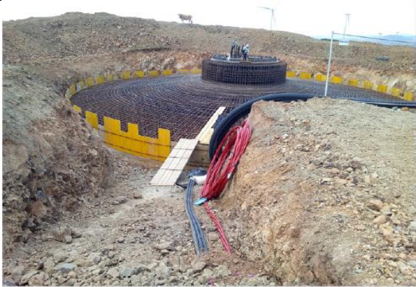
Posa dei ferri e cassetatura
