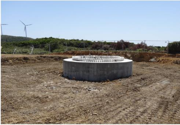
Fase di rinterro parziale del plinto
