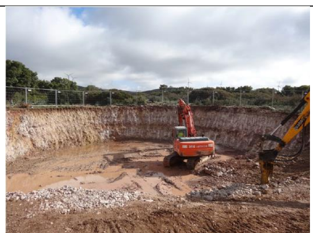
Esempio di Scavo di alloggiamento del basamento
