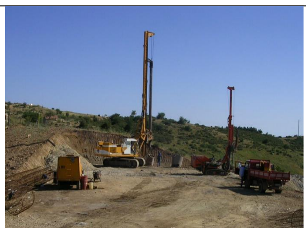
Realizzazione dei pali trivellati
