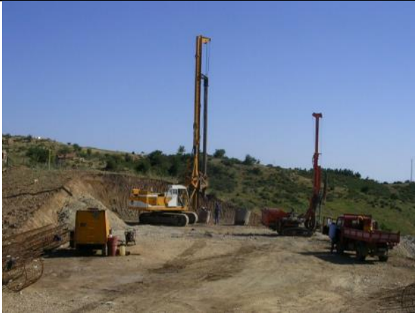
Realizzazione dei pali trivellati
