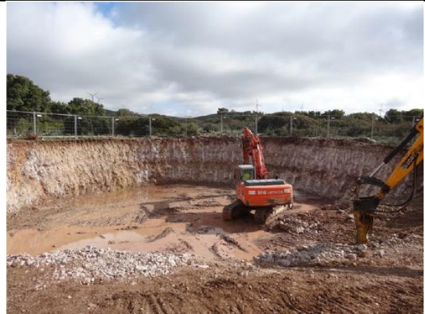
Esempio di Scavo di alloggiamento del basamento
