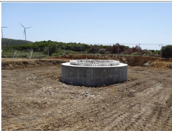
Fase di rinterro parziale del plinto
