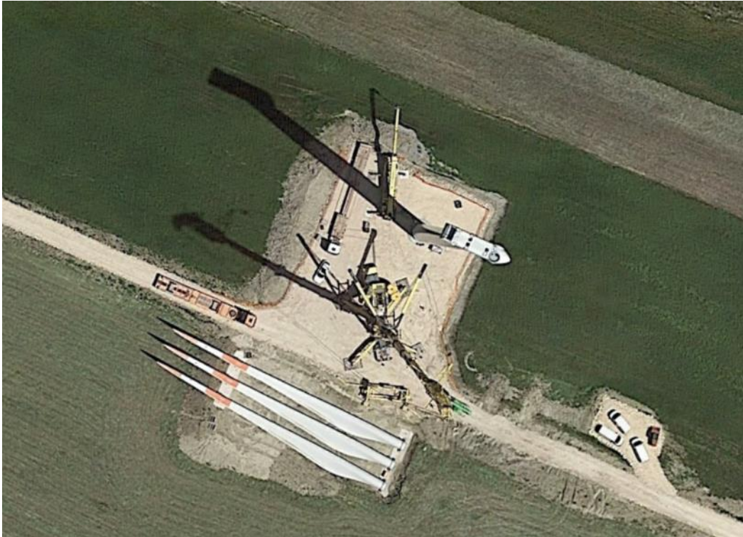
FIGURA 3.6 ESEMPIO DI PIAZZOLA IN FASE DI COSTRUZIONE
