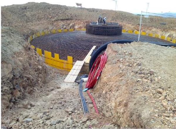
Posa dei ferri e cassetatura
