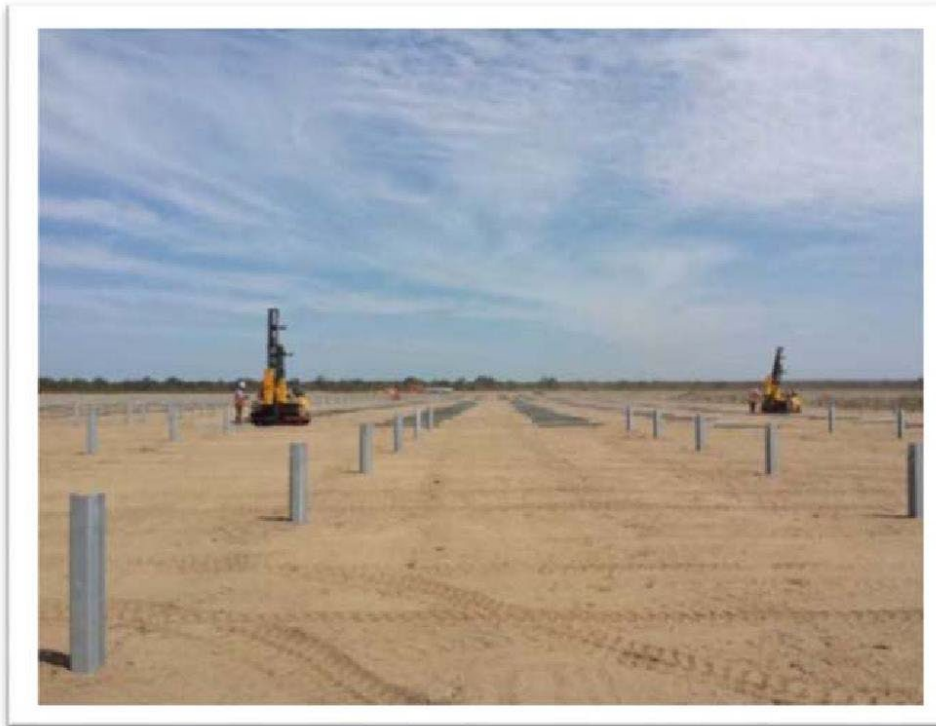
Figura 6.5. – Foto esempio di impianti realizzati con stessa struttura e stessi moduli fotovoltaici
