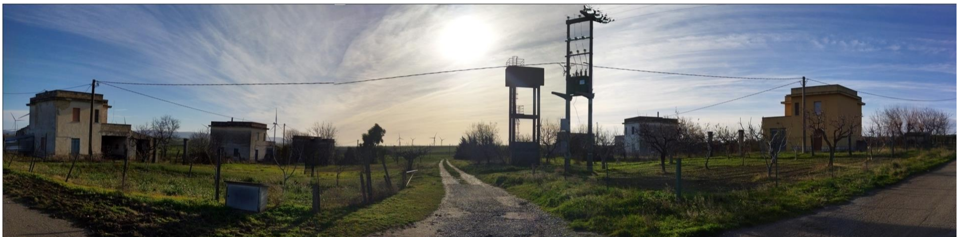
Figura 52: Resa post operam da PV5: "nr 014 - PZ Regio tratturello Stornara-Montemilone"
