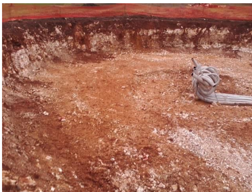
Figura 27: Particolare scavo di sbancamento per fondazioni WTG.
