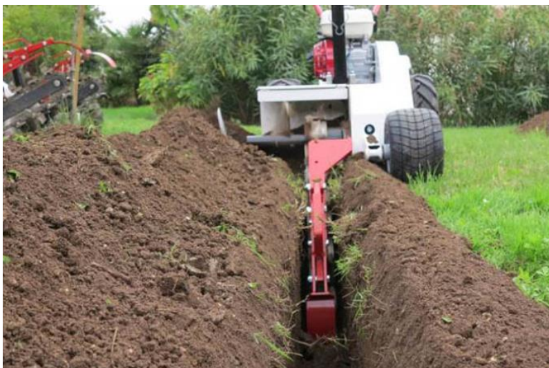
Figura 28: Particolare operazioni di scavo a sezione obbligata.
