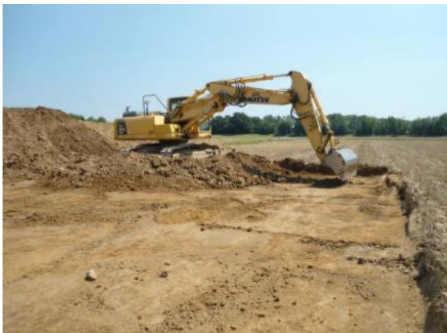
Figura 26: Particolare operazioni di scotico del terreno superficiale.
