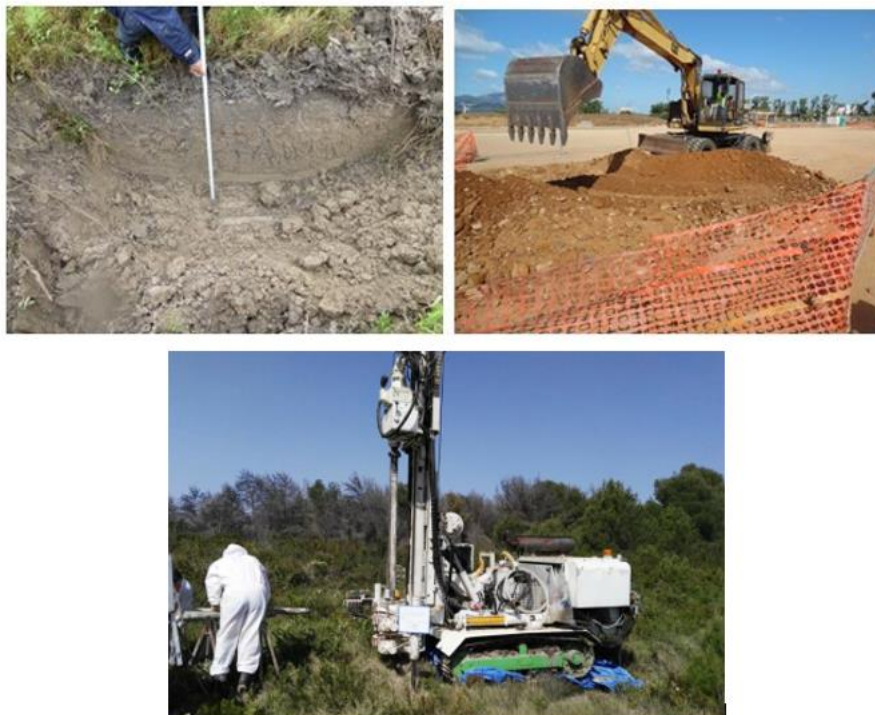
Figura 29: Operazioni di caratterizzazione ambientale da scavo mediante escavatore meccanico (sopra) e da sondaggio (sotto).
